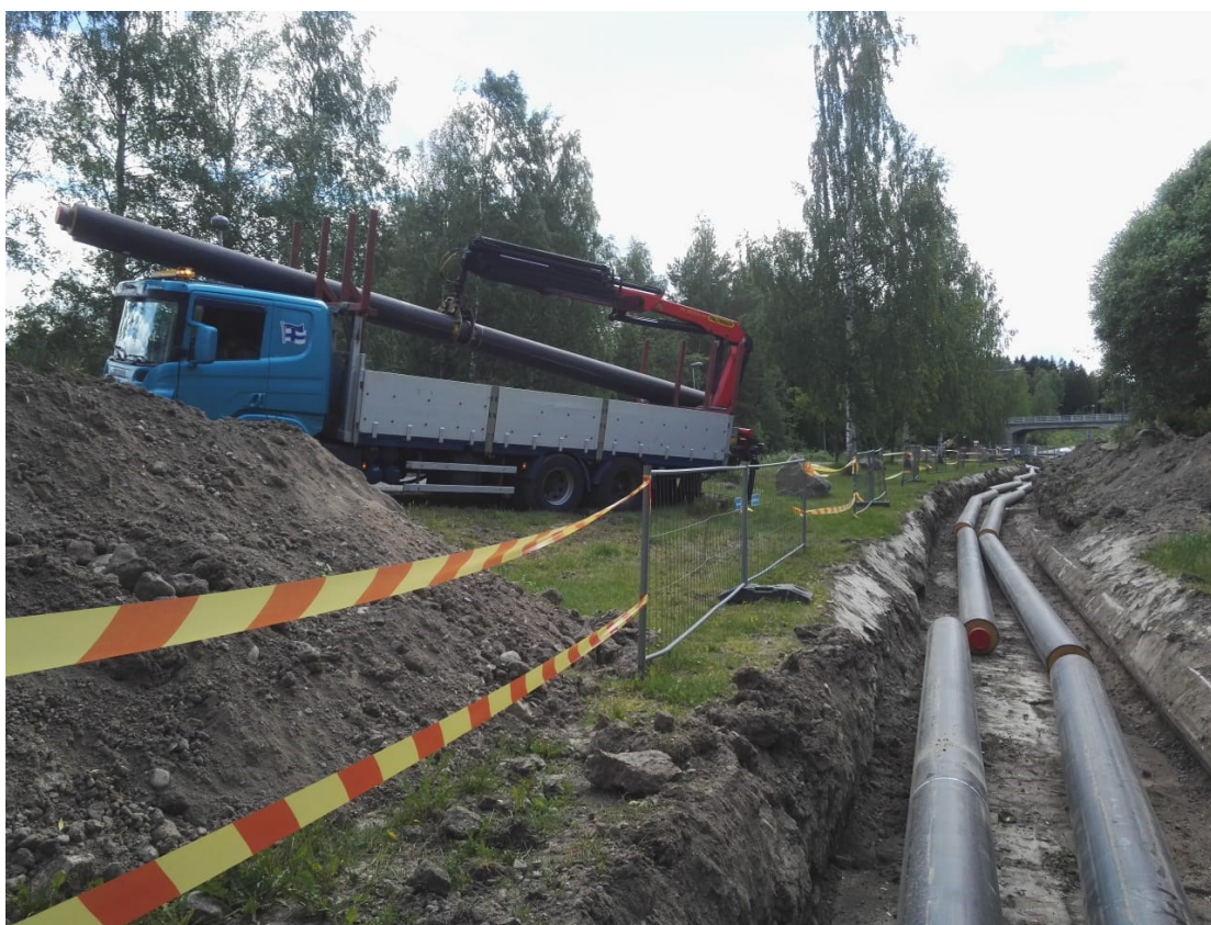
KUVA 3. 2Mpuk kaukolämpörunkolinjan rakentamista Iisalmessa (Räisänen. 2018.)
