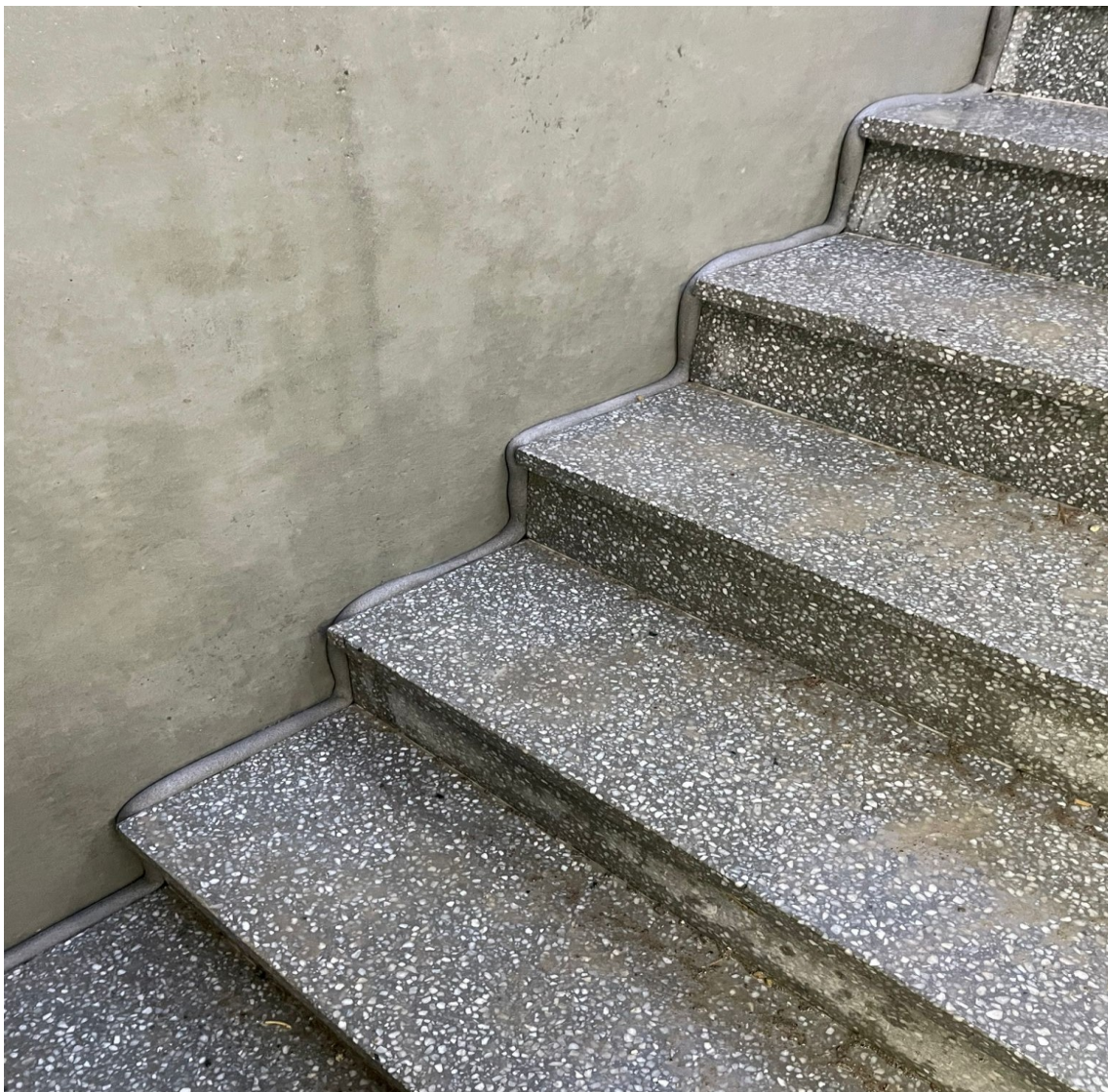
Kuva 14. Pohjanauhan läpi pääsevä vesi ohjautuu alla asennetun väliseinäransasteemin avulla putkilinjastoon.
