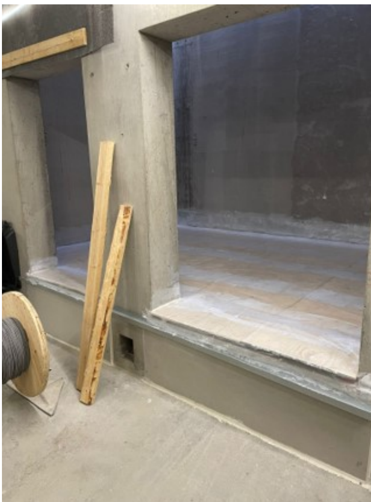
Kuva 15. Hissikuiluun asennettu taso vedeneristyksellä.
