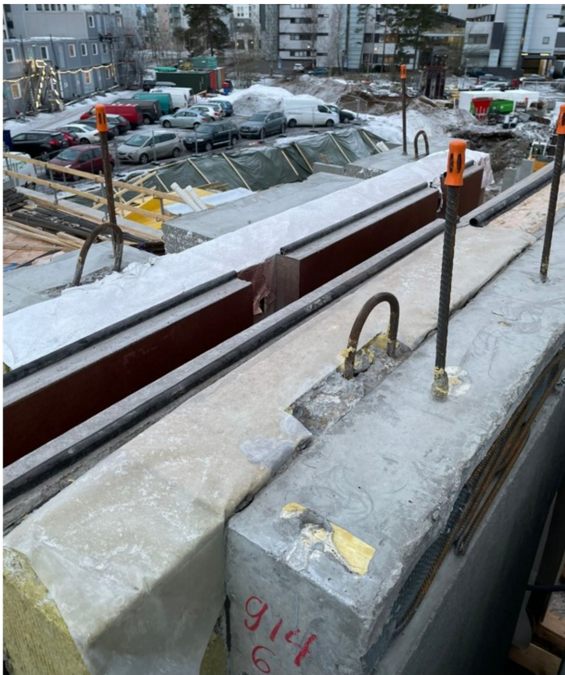
Kuva 12. SW-elementtien villatila suojataan jo tehtaalla.
