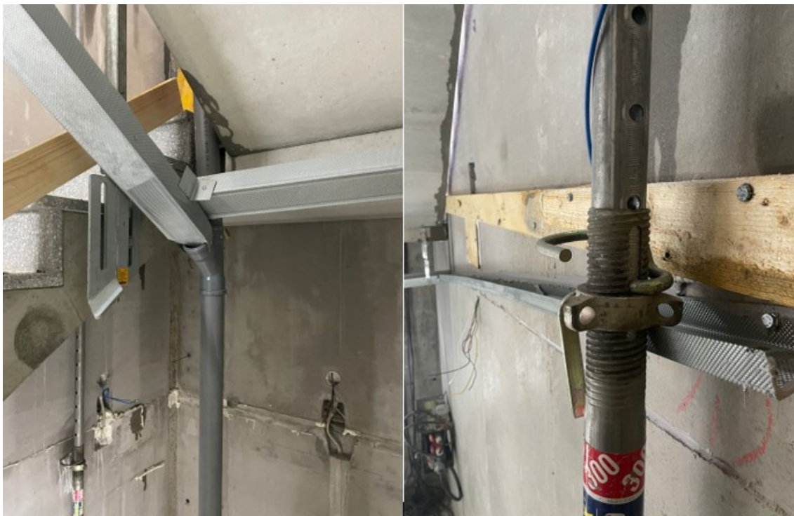
Kuva 13. Väliseinärangan avulla ohjataan vedet väliaikaiseen putkilinjastoon, joka vie veden pois rakennuksesta.
