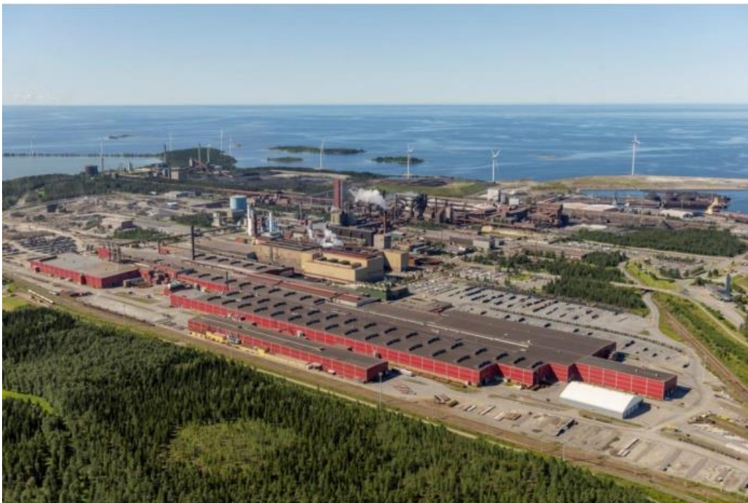
KUVA 1. SSAB Raahen terästehtas (1)
