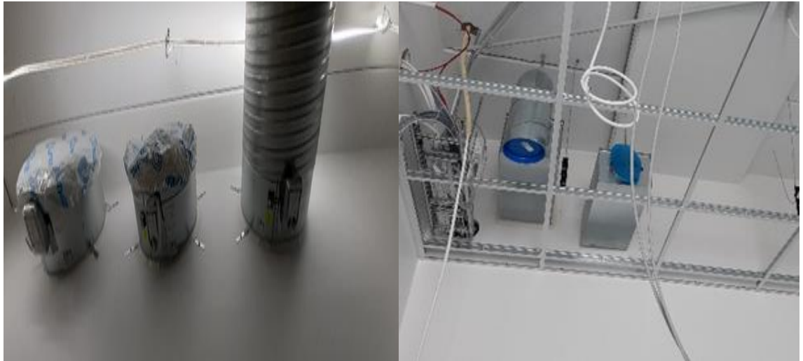
Kuva 16. IV- putkien päät suojattu ja reunat massattu
