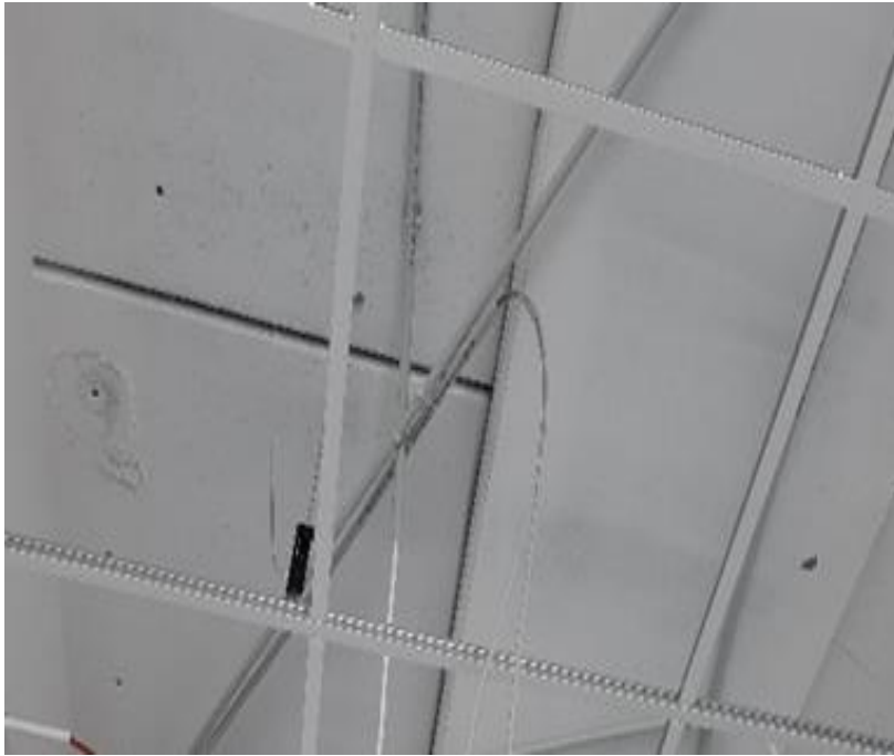
Kuva 11. Pölynsidontamaalaus ontelossa ja palkissa
