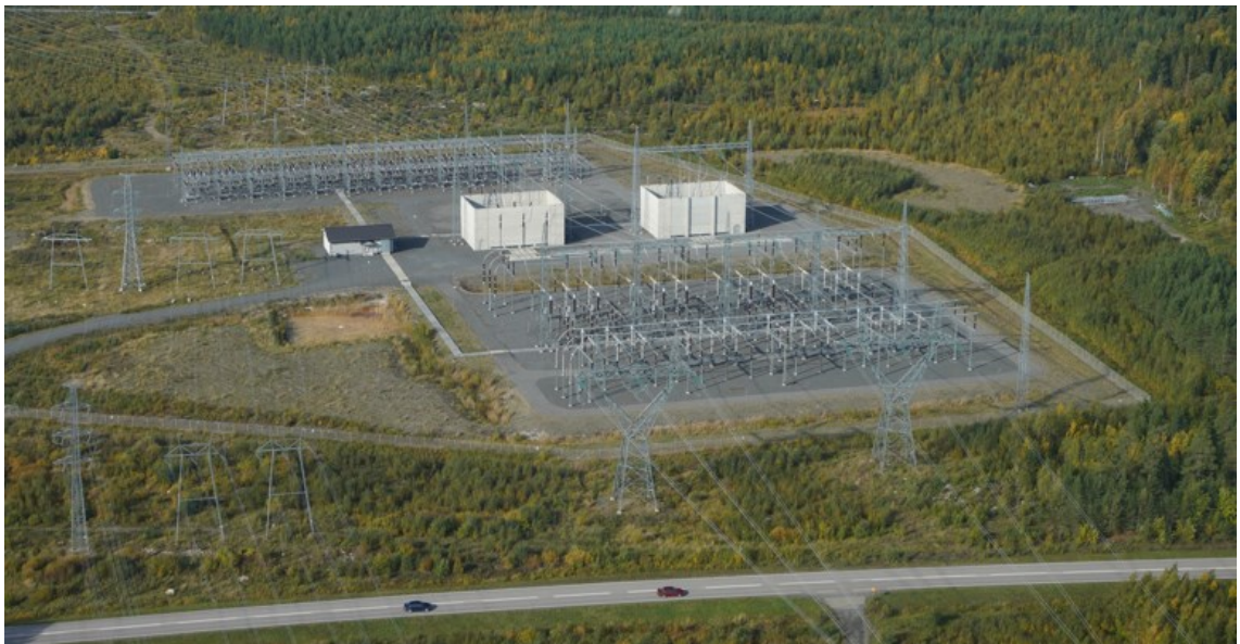
Kuva 2. Kristinestad 400/110 kV muuntoasema. Fingrid [8]
