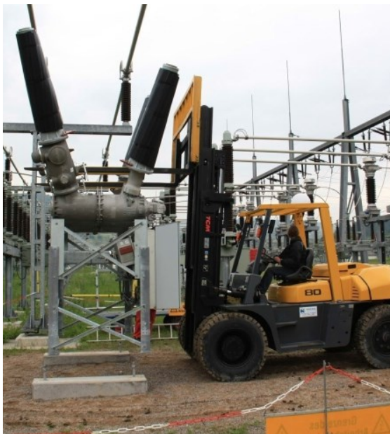
Kuva 15. Dead Tank Compact hybridikojeistomodulin asennus. Siemens Energy [35]
