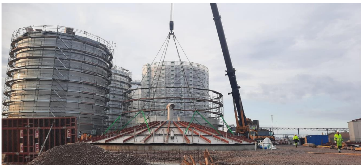
Kuva 1. Työmaalla tehtävä organisointi vaikuttaa kokonaisuuteen.
