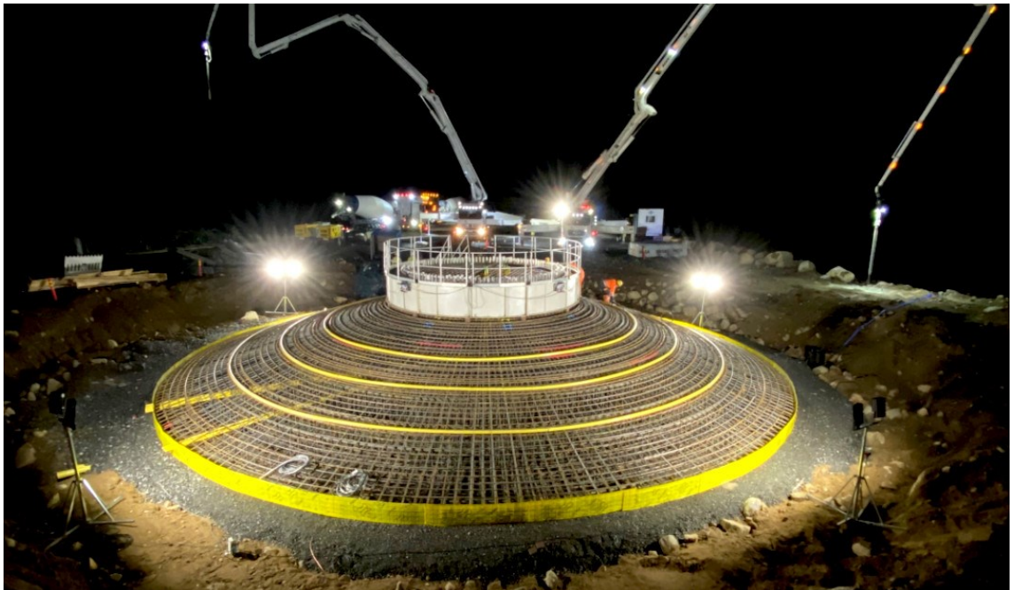
Kuva 6. Gravitaatio perustus valmiina betonointiin (Suvic Oy)
