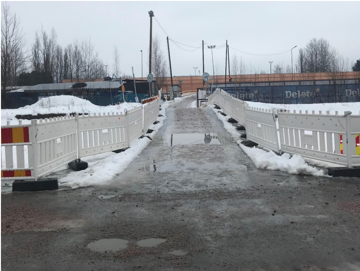
Kuva 9. Kevyellä työmaa-aidalla rajattu kulkuväylä helmikuussa.
