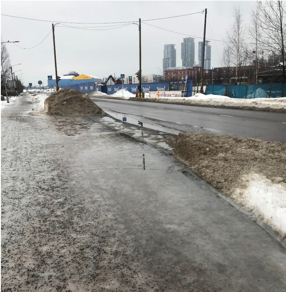
Kuva 22. Työnaikaisen bussipysäkin pysäkkisyvennys aurattu umpeen.
