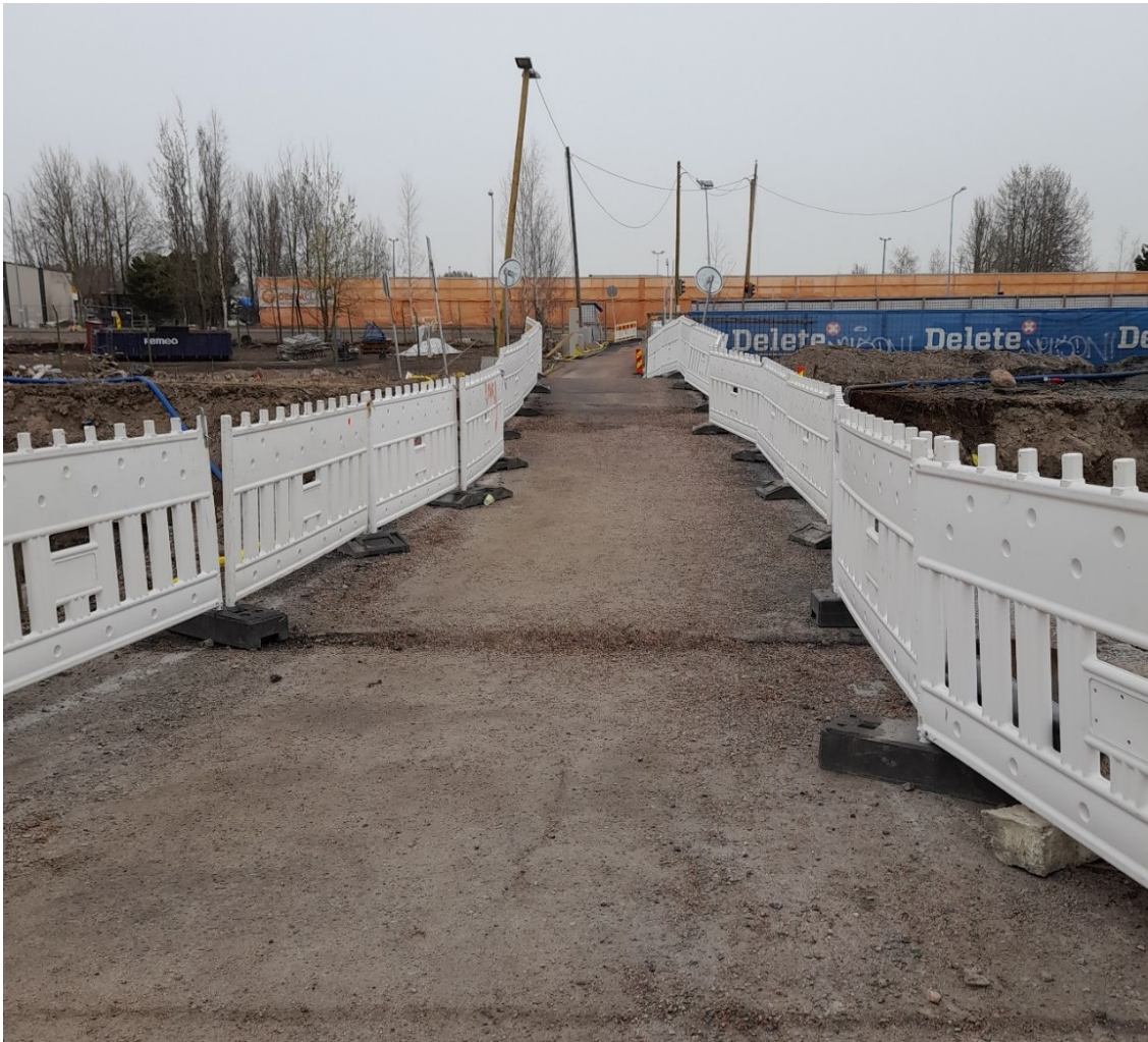
Kuva 11. Kevyellä työmaa-aidalla rajattu kulkuväylä huhtikuussa.
