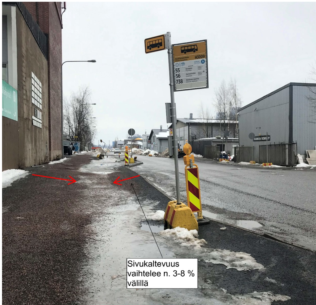
Kuva 23. Työnaikaisen bussipysäkin odotustila.
