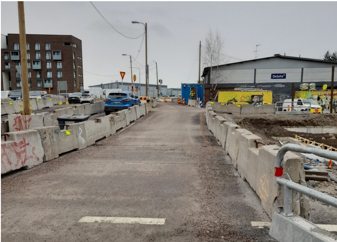
Kuva 12. Raskassuojilla rajattu kulkuväylä huhtikuussa.
