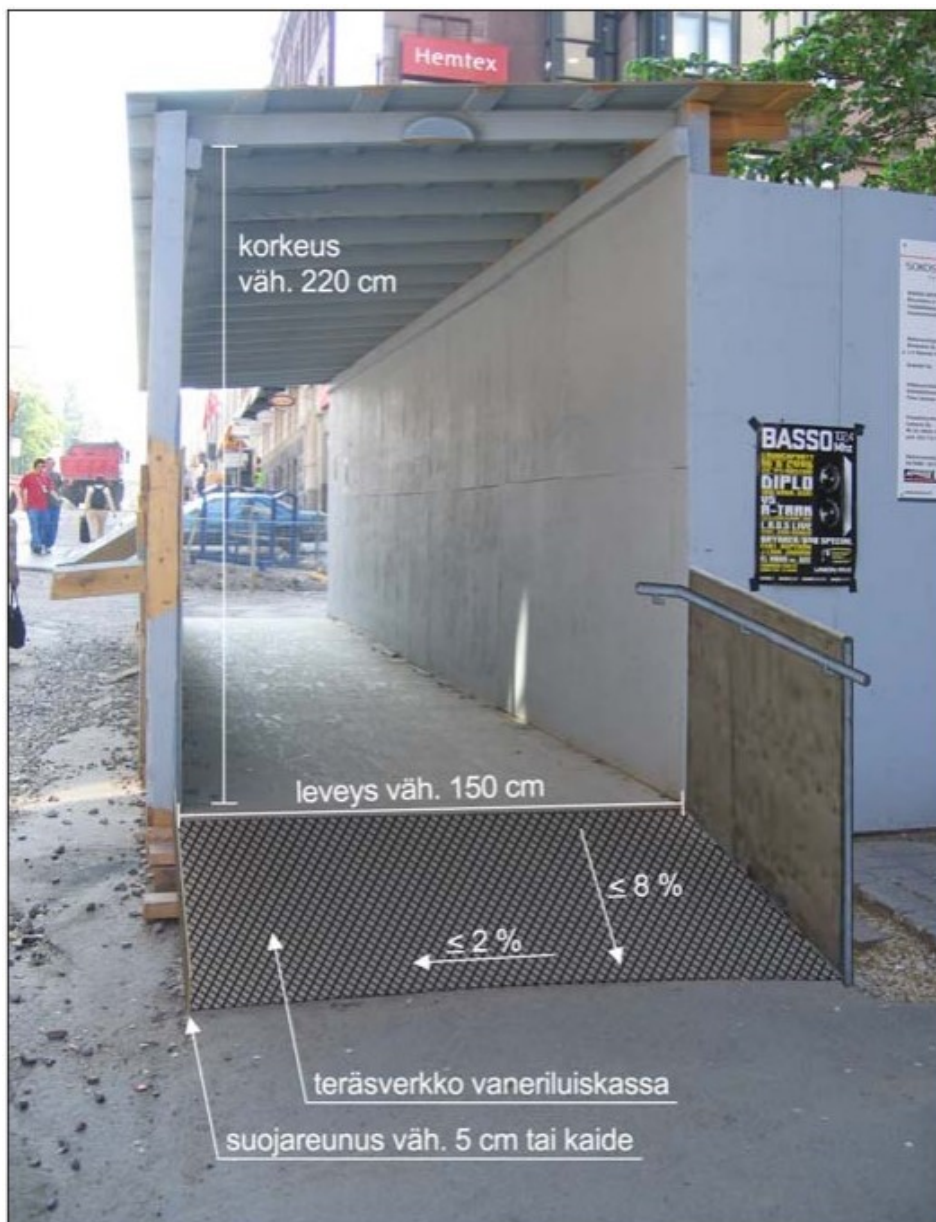
Kuva 2. Tilapäinen katettu jalankulkuväylä ja luiska (SuRaKu-projekti, 2008a).
