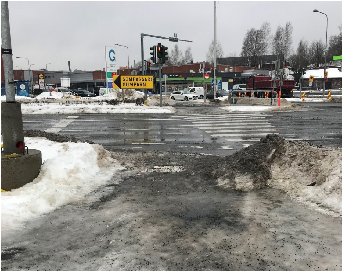
Kuva 17. Suojatien kohdalle kasaantunut lumi voi aiheuttaa vaaratilanteita.
