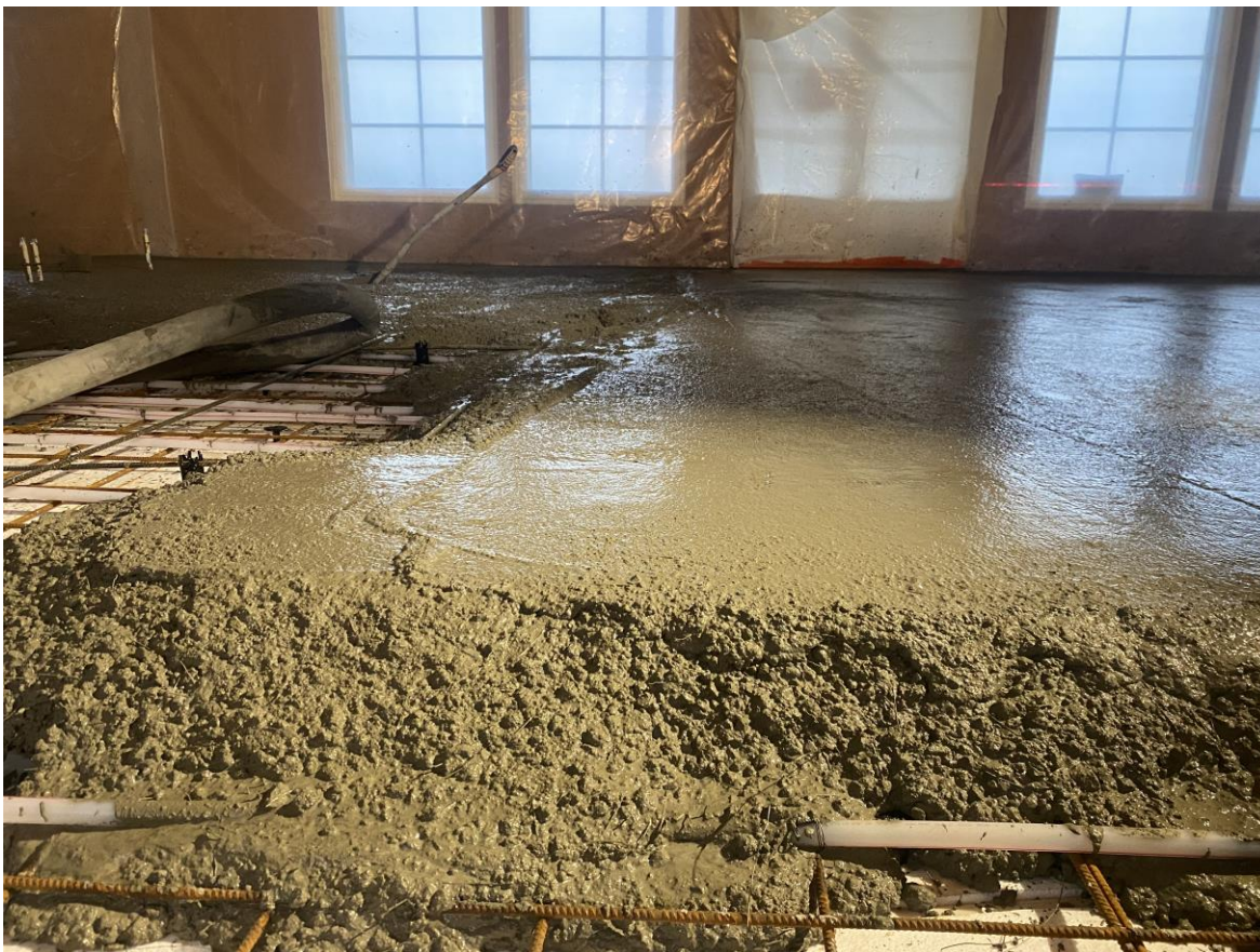
Bild från pågående golvgjutning i egnahemshus.
