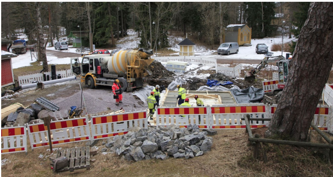
Kuva 13. Pikku-Helsinki-museopihan maanrakennus- ja perustamistyöt tehtiin kevättalvella 2016. Kuva Museovirasto.
