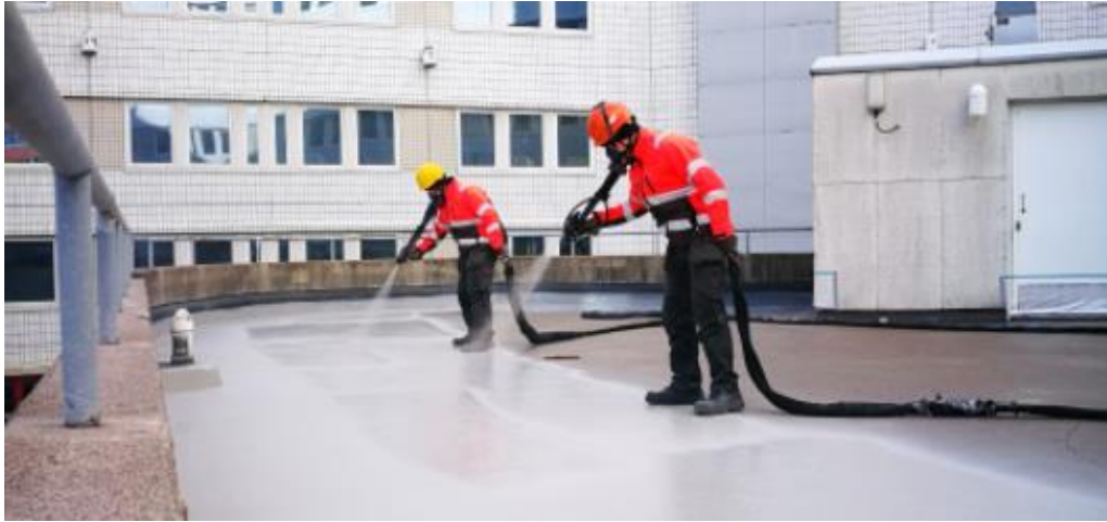
Kuva 23. Polyurean asennusta primeroidulle betonipinnalle. (Lännen pinnoitetyö, 2021)
