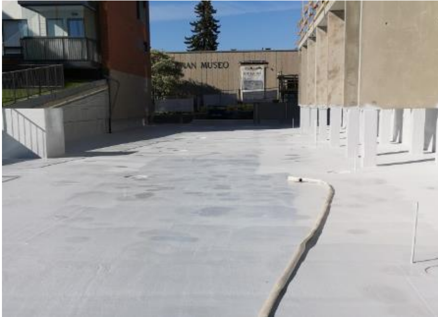
Kuva 15. Pihakannelle asennettu polyurea. (Lännen pinnoitetyö, 2021)
