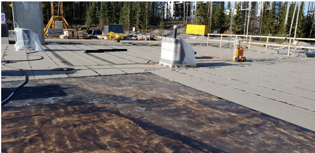
Kuva 21. Ensimmäisen kermikerroksen asennusta (Vaimare, 2021)
