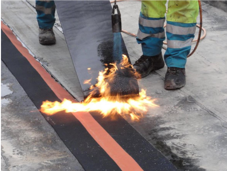
Kuva 22. Irrotuskaistan asennus bitumikermiä käytettäessä (Flexjoint www-sivut 2021)
