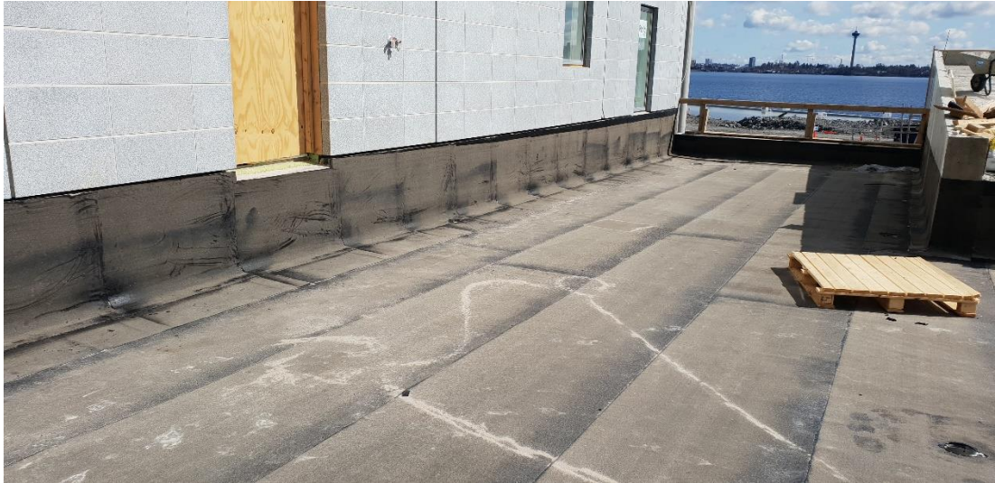
Kuva 12. Vedeneristyksen (bitumikermi) ylösnosto (Vaimare, 2021)
