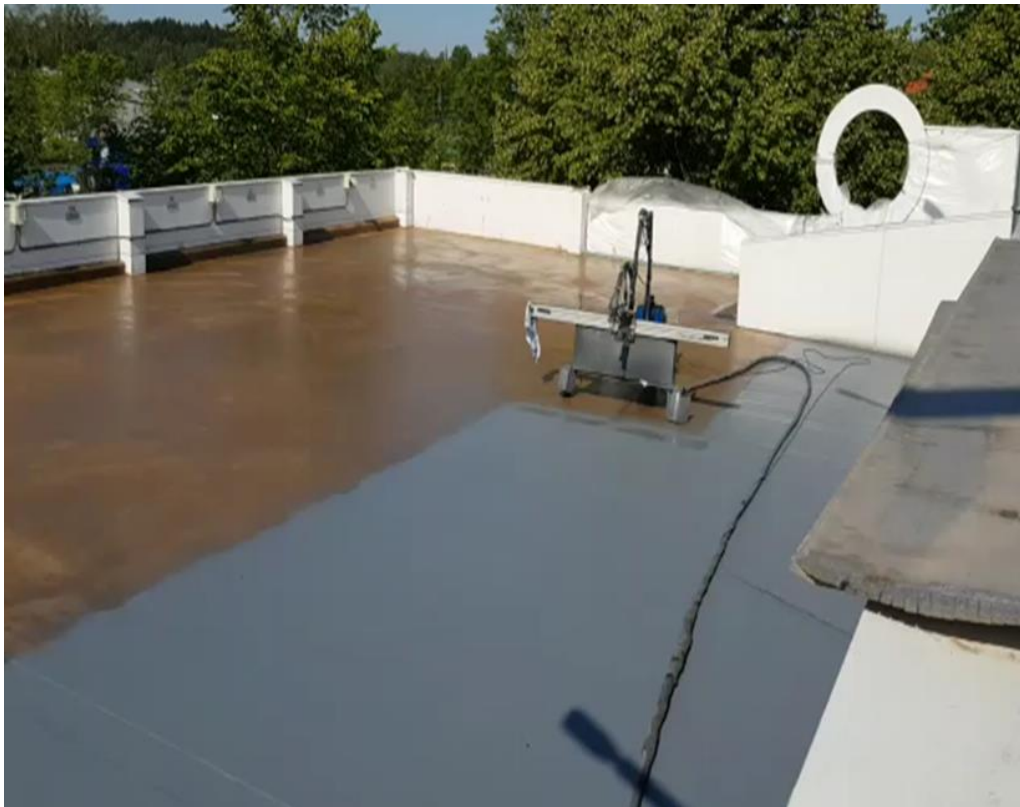
Kuva 24. Polyurean asennusta primeroidulle betonipinnalle robotilla. (Kotek Factory Service, 2021)
