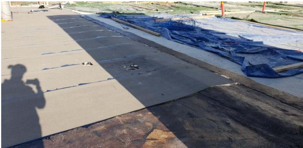
Kuva 8. Pohjakermin asennusvaihe liikuntasauman harjakohtaan (Vaimare, 2021)
