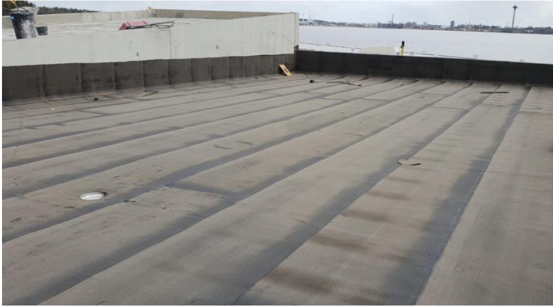
Kuva 13. Pihakannelle asennettu bitumikermi. (Vaimare, 2021)
