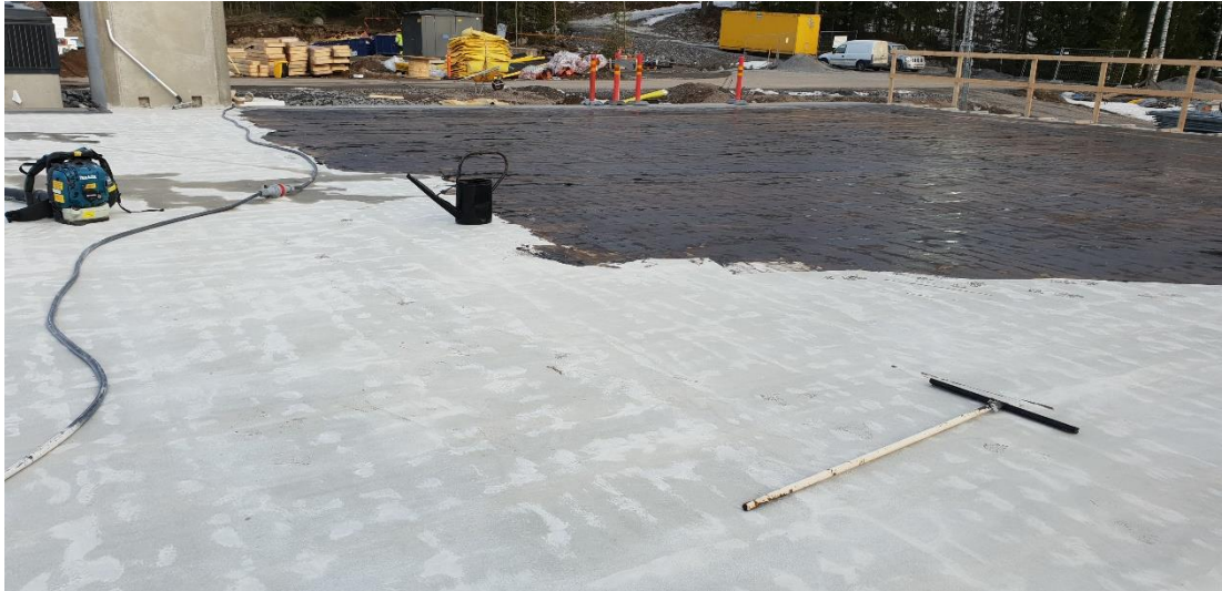
Kuva 20. Liuoksen levitystä hiotulle ja pestylle betonipinnalle (Vaimare, 2021)
