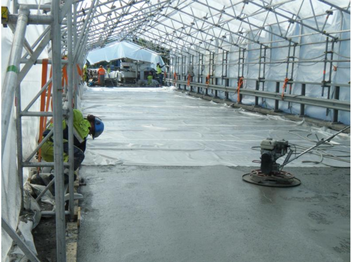
KUVA 3. Muotoiluvalun teko käynnissä Laanilan risteyssillalla kesällä 2012 (Kuva: Toni Gussander)
