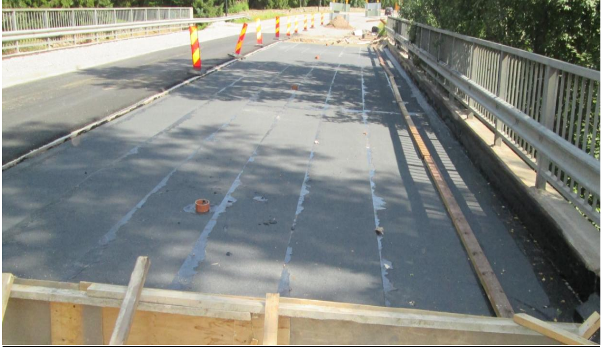
KUVA 4. Tyrnävän kirkkosillan valmis kermieristys kesällä 2013 (Kuva: Juuso Mattila)
