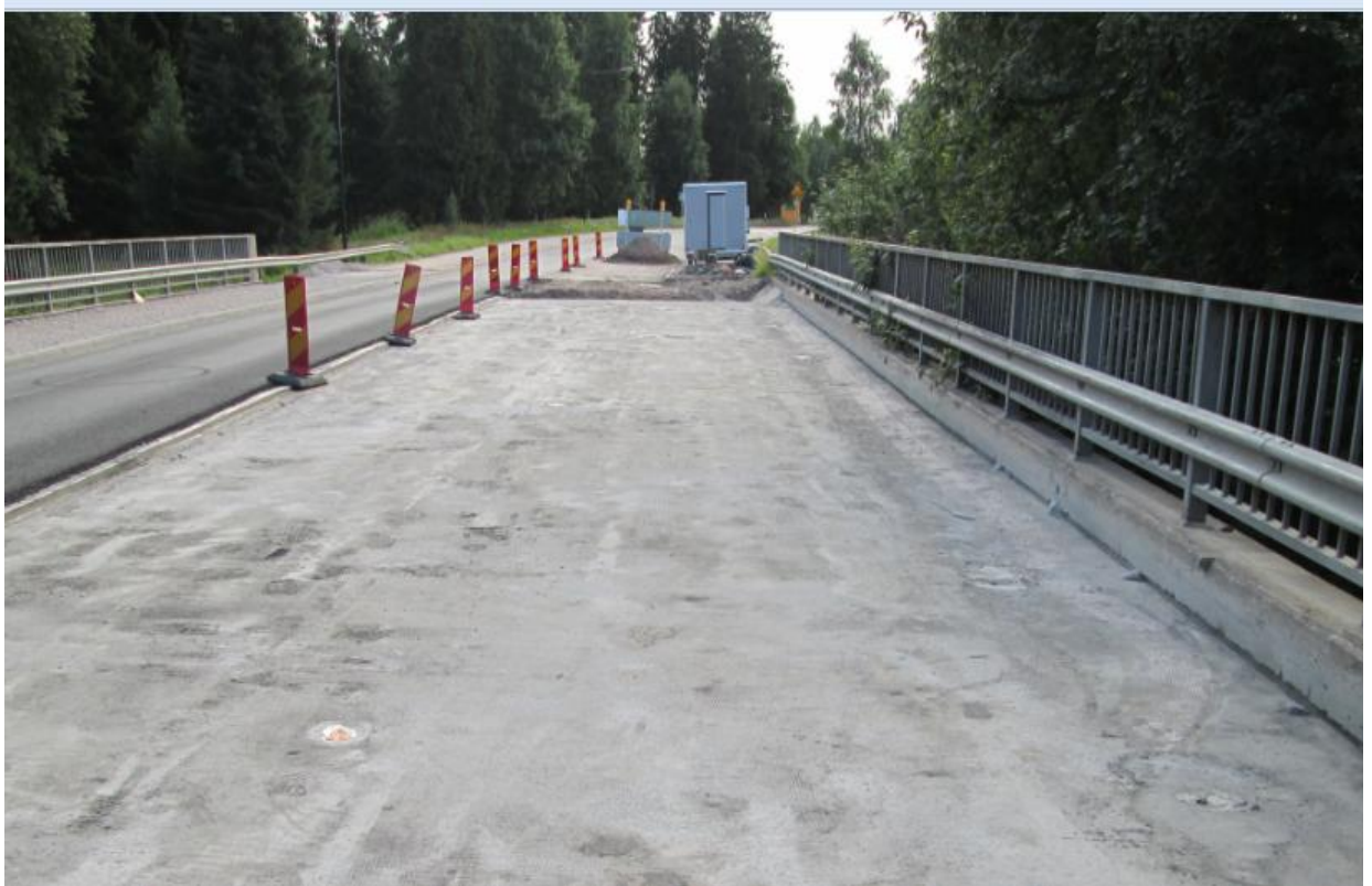
KUVA 10. Toisen vaiheen eristysalusta valmiina suihkupuhdistusta varten, liikenne kulkee valmiilla ajoradalla vasemmalla
