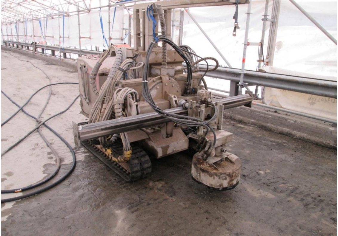
KUVA 2. Vesipiikkausrobotti (Kuva: Juuso Mattila)
