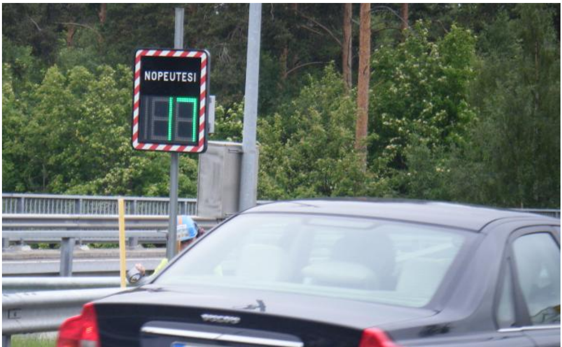
KUVA 11. Siirrettävä nopeusnäyttö Laanilan risteyssillan korjaustyömaalla kesällä 2012 (Kuva: Toni Gussander)
