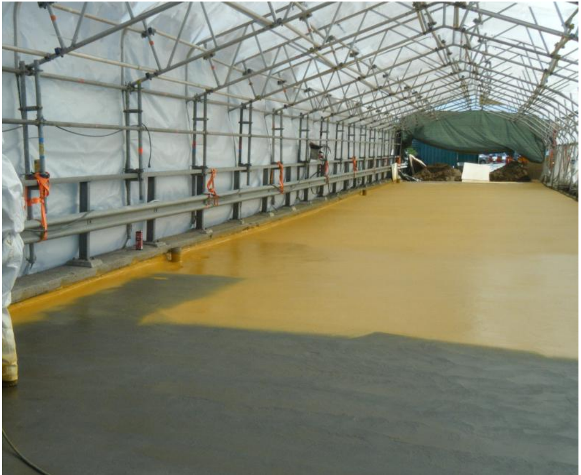
KUVA 5. Nestemäisenä levitettävän eristyksen tekoa sääsuojassa Laanilan Risteys- teyssilloilla kesällä 2012 (Kuva: Toni Gussander)
