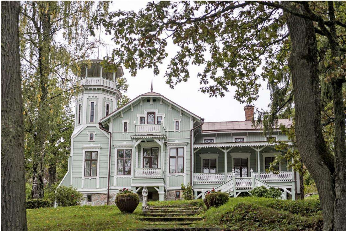
KUVA 3. Vuonna 1878 rakennetusta Villa Junnilasta löytyy ajalle tyypillinen näkötorni sekä lehtisahausin koristellut verannat ja parvekkeet (14)
