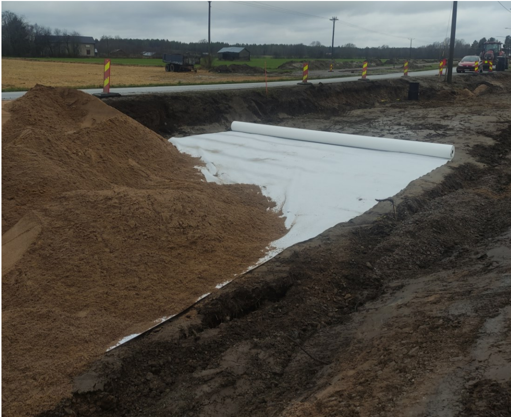
KUVA 5. Maaleikkausta ja suodatinkerroksen tekoa
