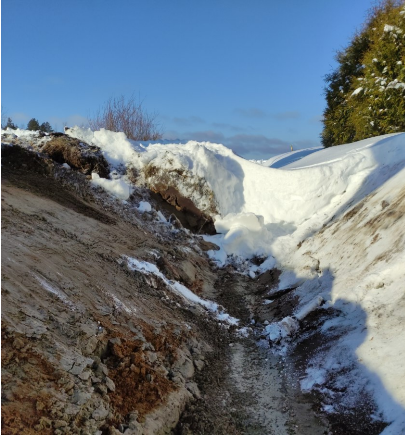
KUVA 10. Runsasluminen talvi hidasti sivu- ja laskuojien kaivuuta
