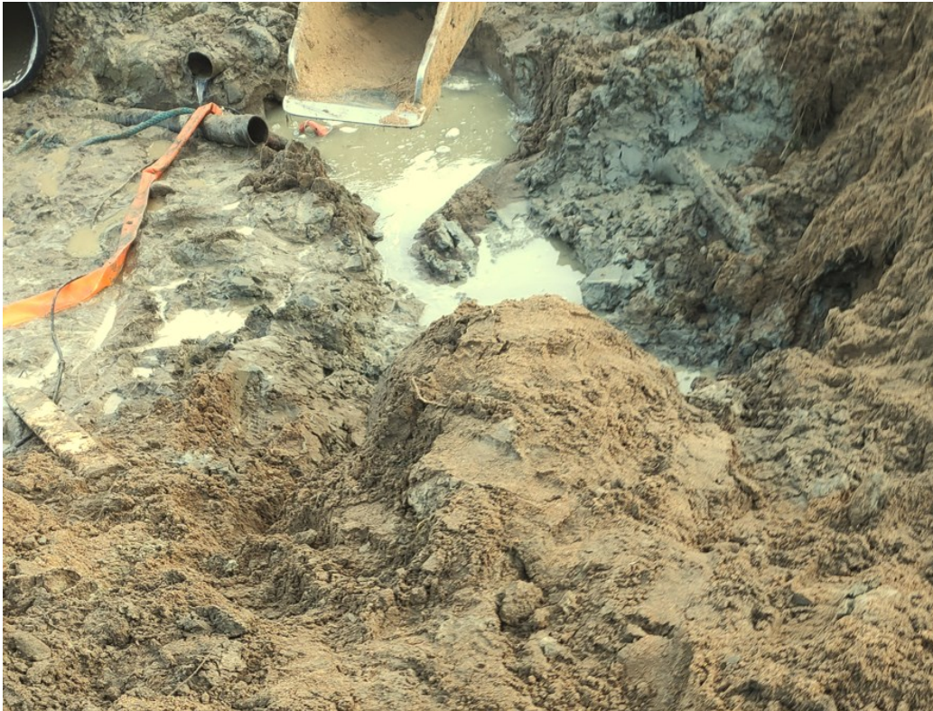
KUVA 9. Vesi aiheutti haasteita putkitustöissä
