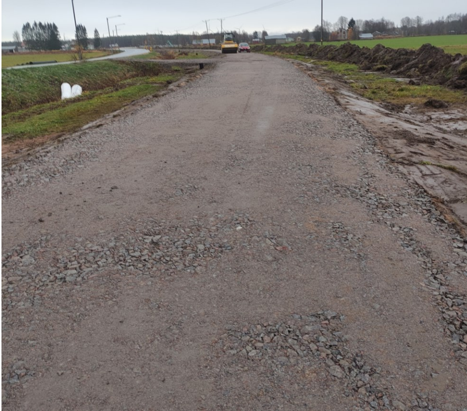
KUVA 7. Valmista jakavan kerroksen pintaa
