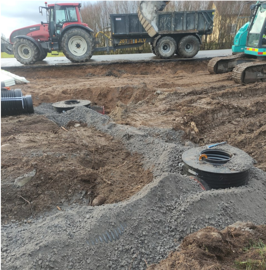
KUVA 6. Salaoja- ja hulevesiputkien rakennusta
