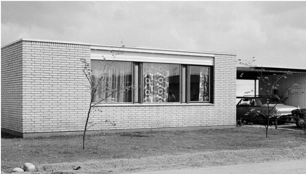
KUVA 9. Tyypillinen tasakattoinen tiilitalo suurine ikkunoineen 1970-luvun alussa (MTV 2014)
