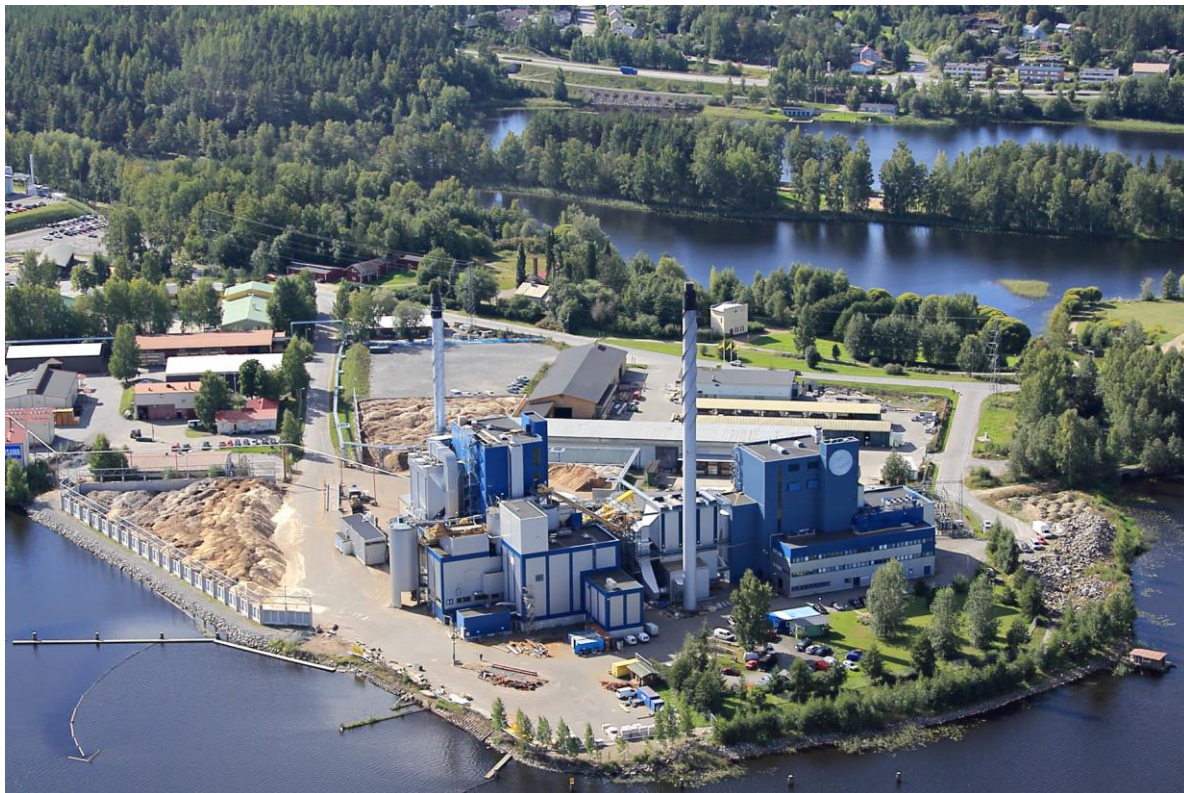
Kuva 10. Pursialan Voimalaitos toimii yhteistuotantoyksikkönä ja tuottaa sähkön lisäksi lämpöä ja teollisuushöyryä. Voimalaitos käyttämä puupohjainen polttoaine koostuu muun muassa metsähakkeesta, puunjalostusteollisuuden sivutuotteista ja kierrätyspuusta. Puupolttoaineiden osuus on noin 85 % koko polttoaineen kulutuksesta. Kuva ESE.
