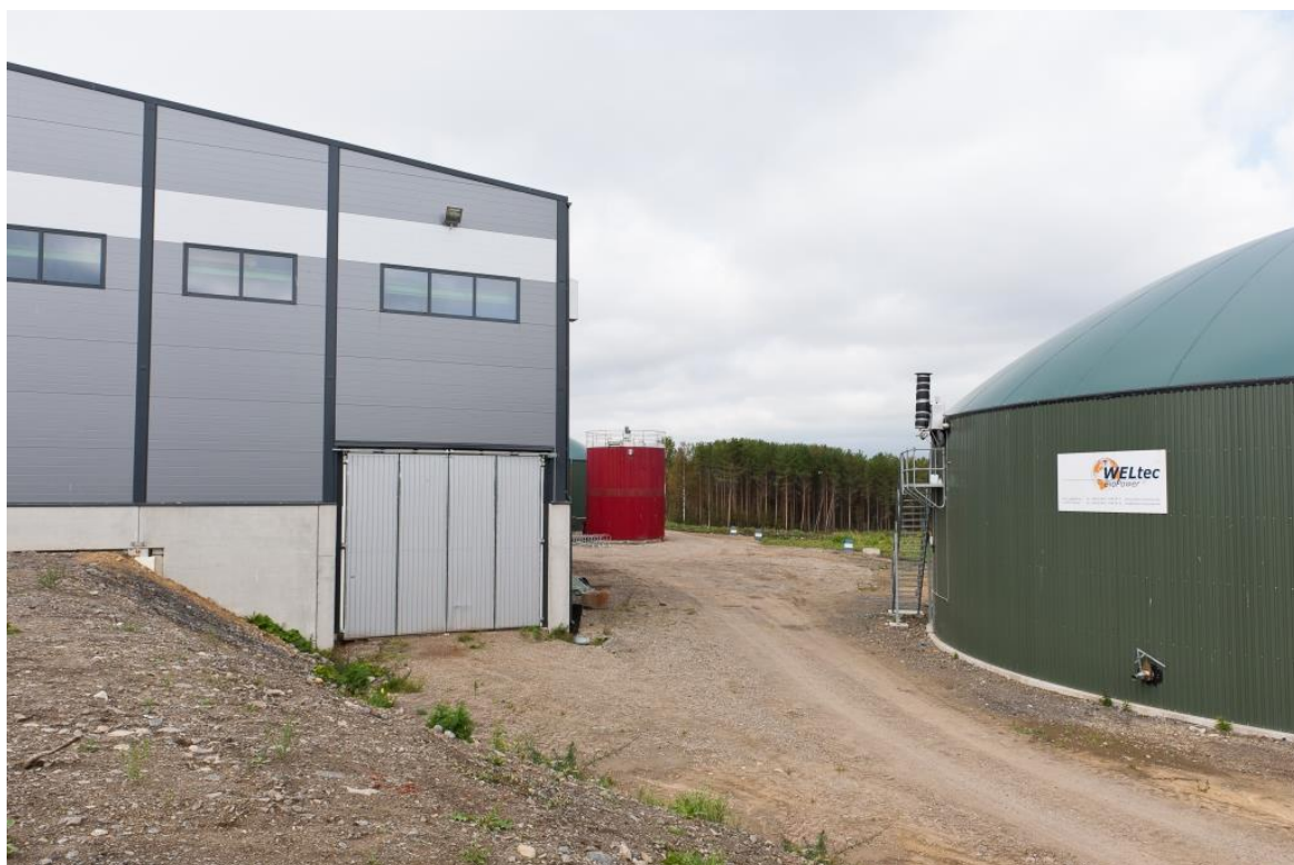
Kuva 11. Etualalla vasemmalla on BioKymppi Oy:n yhteistuotantolaitoksen biomassan esikäsittelylaitos ja oikealla reaktori, jonka päällä on kaasuvälikamari. Kuva Mika Juvonen.
