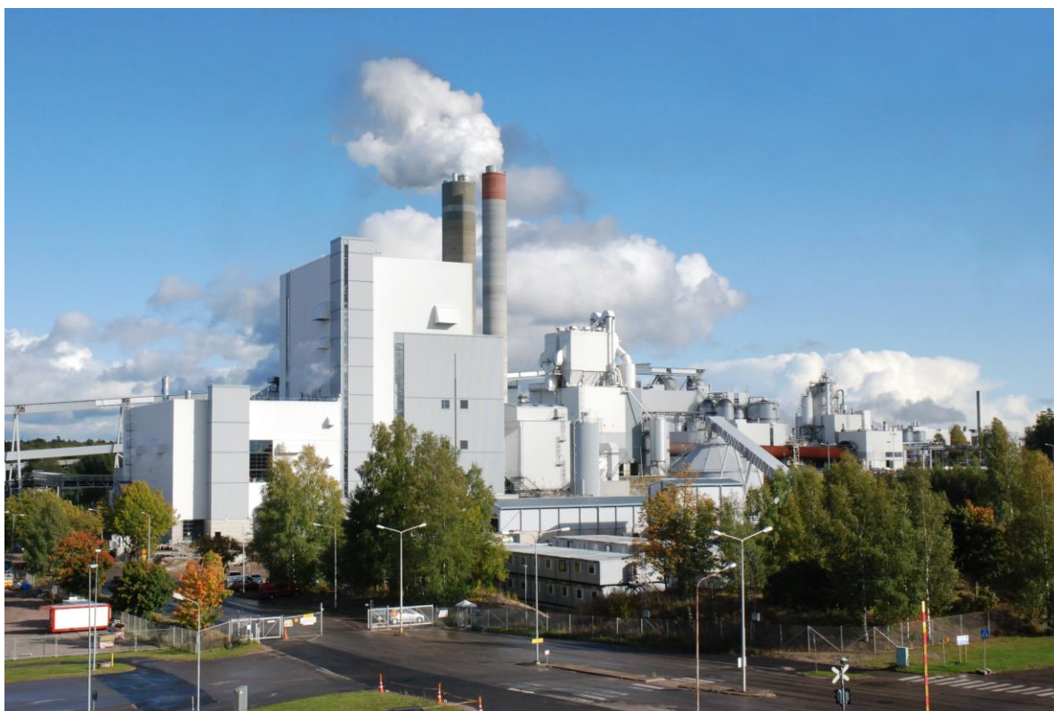
Kuva 9. Kaukaan Voiman voimalaitos sijaitsee UPM:n tehdasalueella Lappeenrannassa. Voimalaitoksen käyttämät polttoaineet ovat 80 %:sti biopolttoaineita. 40 % käytetyistä polttoaineista on UPM:n tehtaan sivuvirtoja. Kuva Kaukaan Voima Oy.
