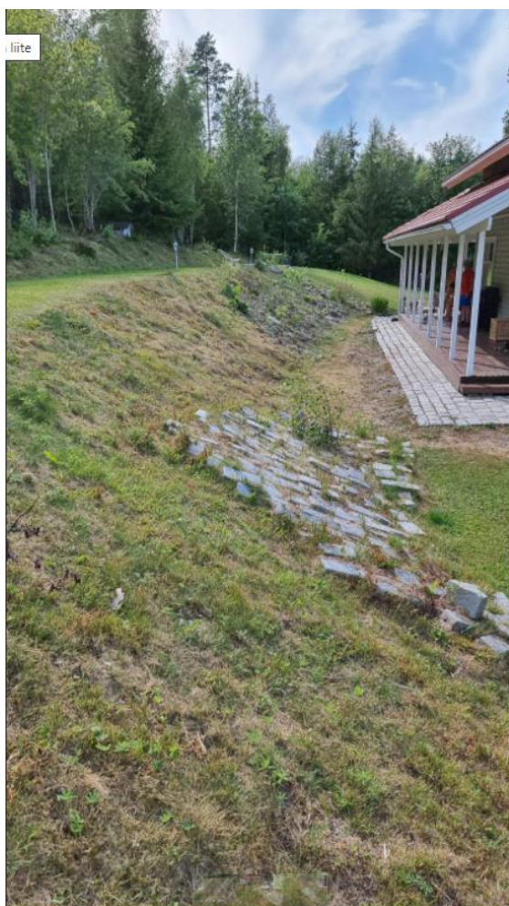
Kuva 9. Aloituskatselmuskuva esimerkkikohteesta. (PMP-Asennus Oy, 2022)
