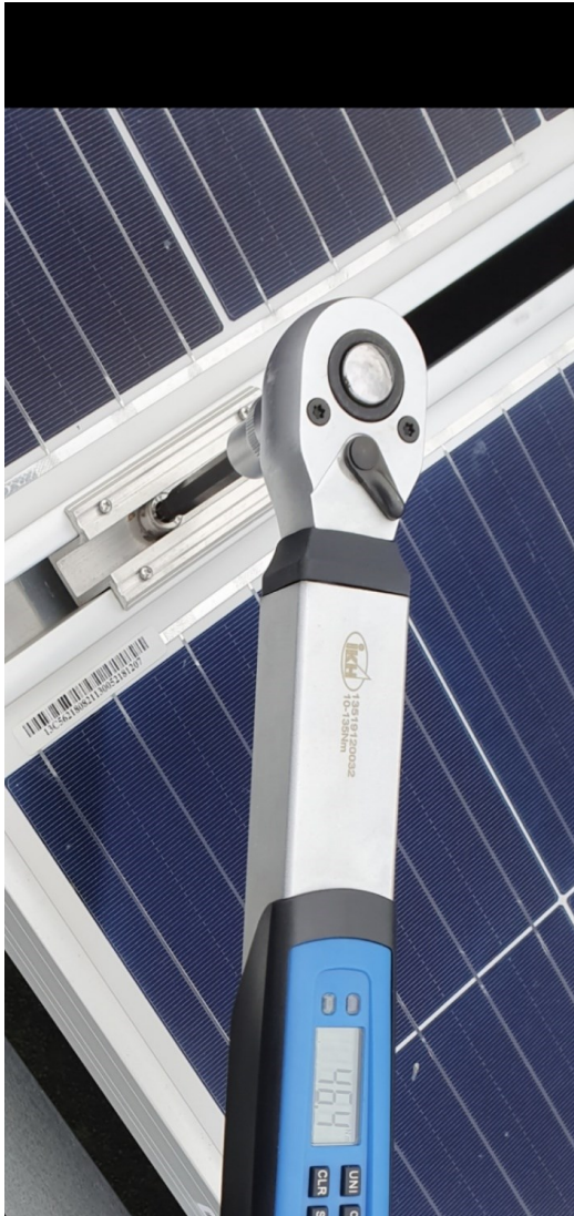
Kuva 11. Paneelikiinnikkeiden kireyden tarkastus momenttiavaimella.
