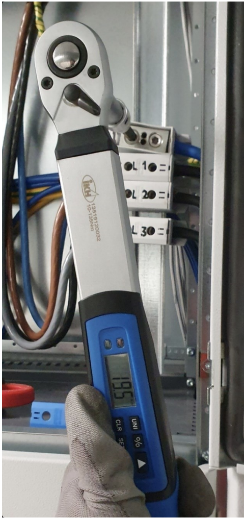
Kuva 8. Aurinkosähköjärjestelmän AC-liitoksien tarkastus momenttiavaimella.
