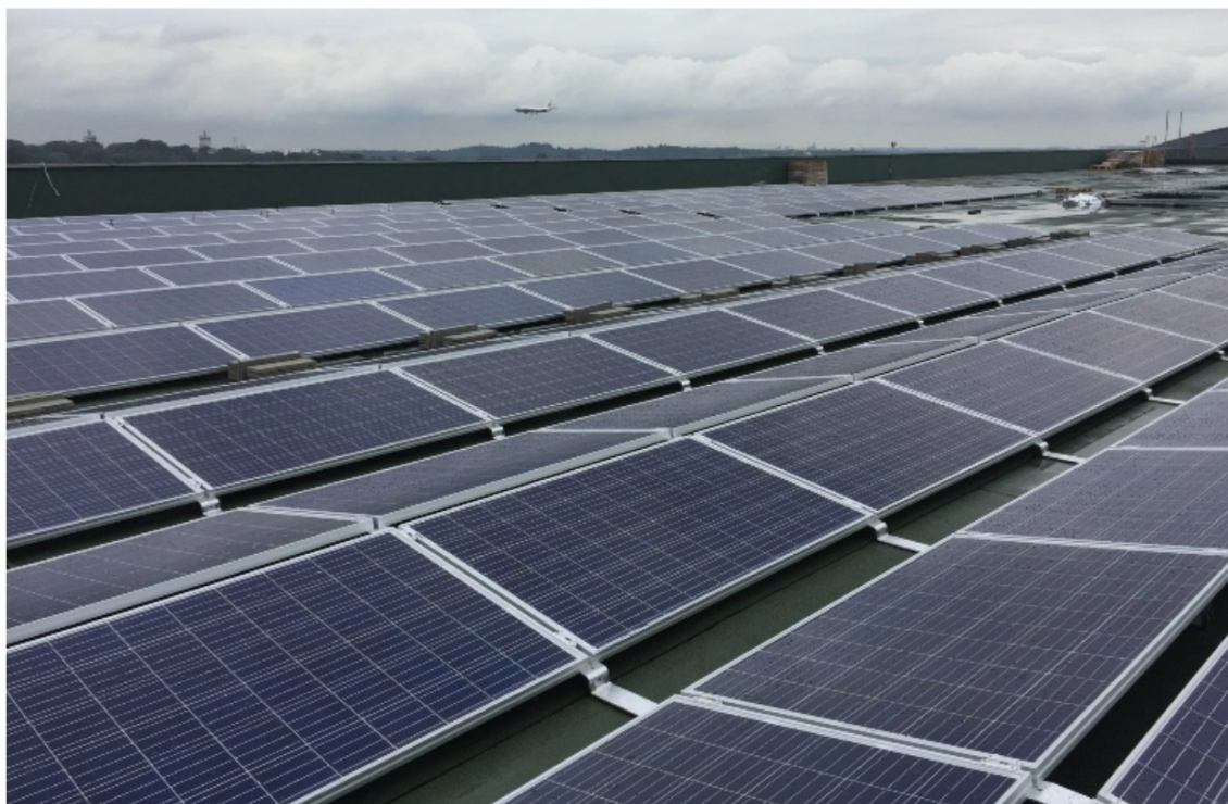
Kuva 2. Aurinkopaneeliasennus itä-länsi suuntauksella.
