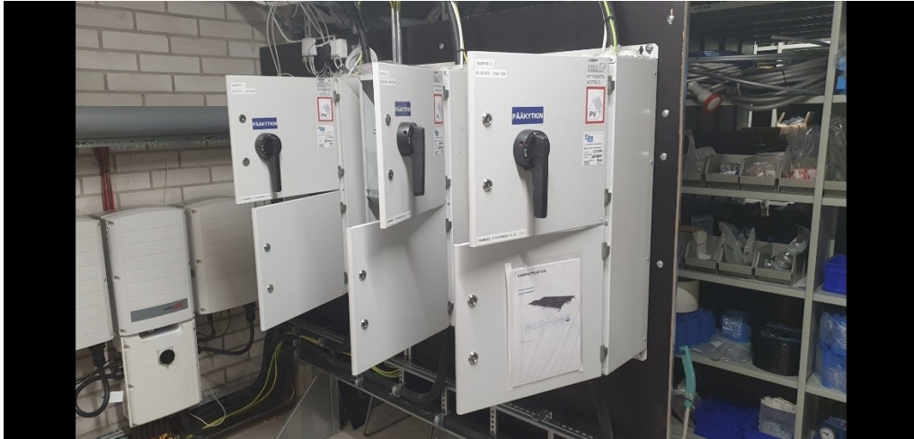
Kuva 5. Aurinkosähköjärjestelmän AC-kytkentäkeskukset.
