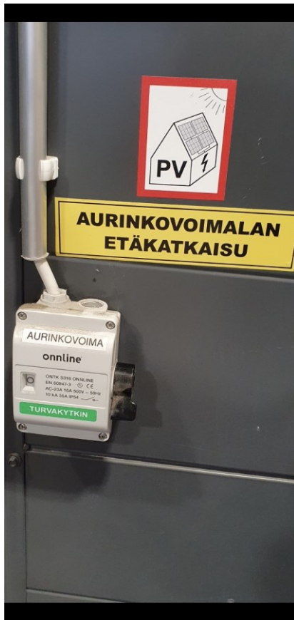
Kuva 7. Aurinkosähköjärjestelmän hätäkatkaisukytkin.
