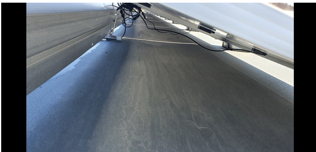
Kuva 10. Aurinkosähköjärjestelmän puhtauden tarkastus.
