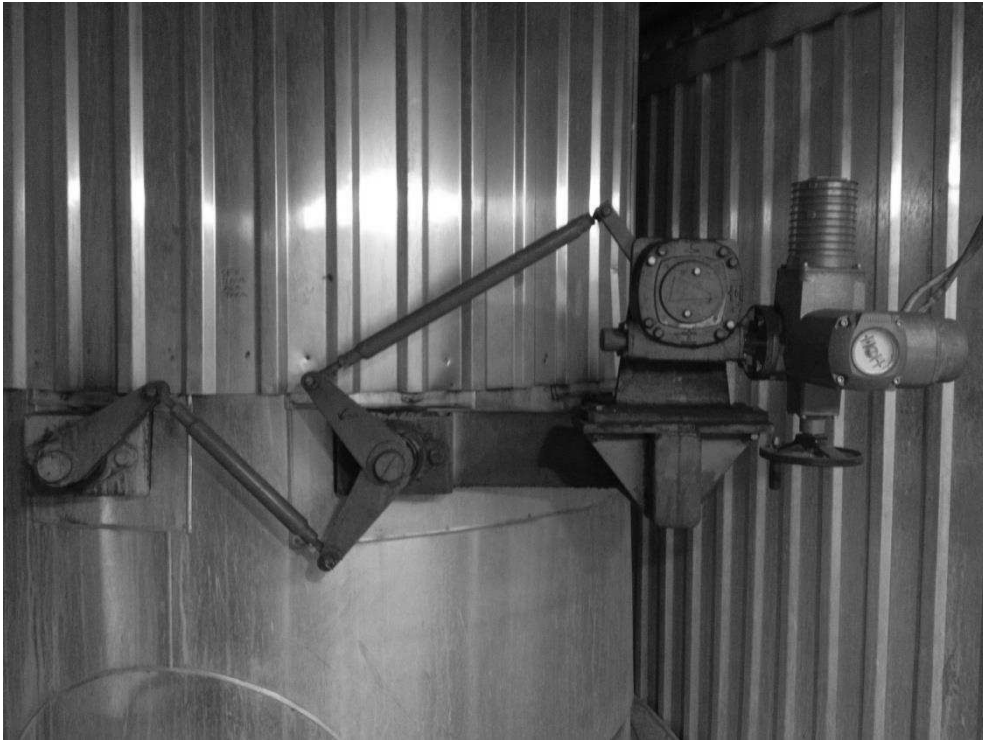
KUVA 6. Primääri-ilman säätöpelti
