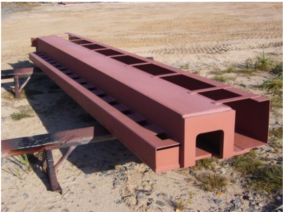
Kuva 10. WQ-palkki valukotelolla. (Oy Labcor Ab www-sivut)
