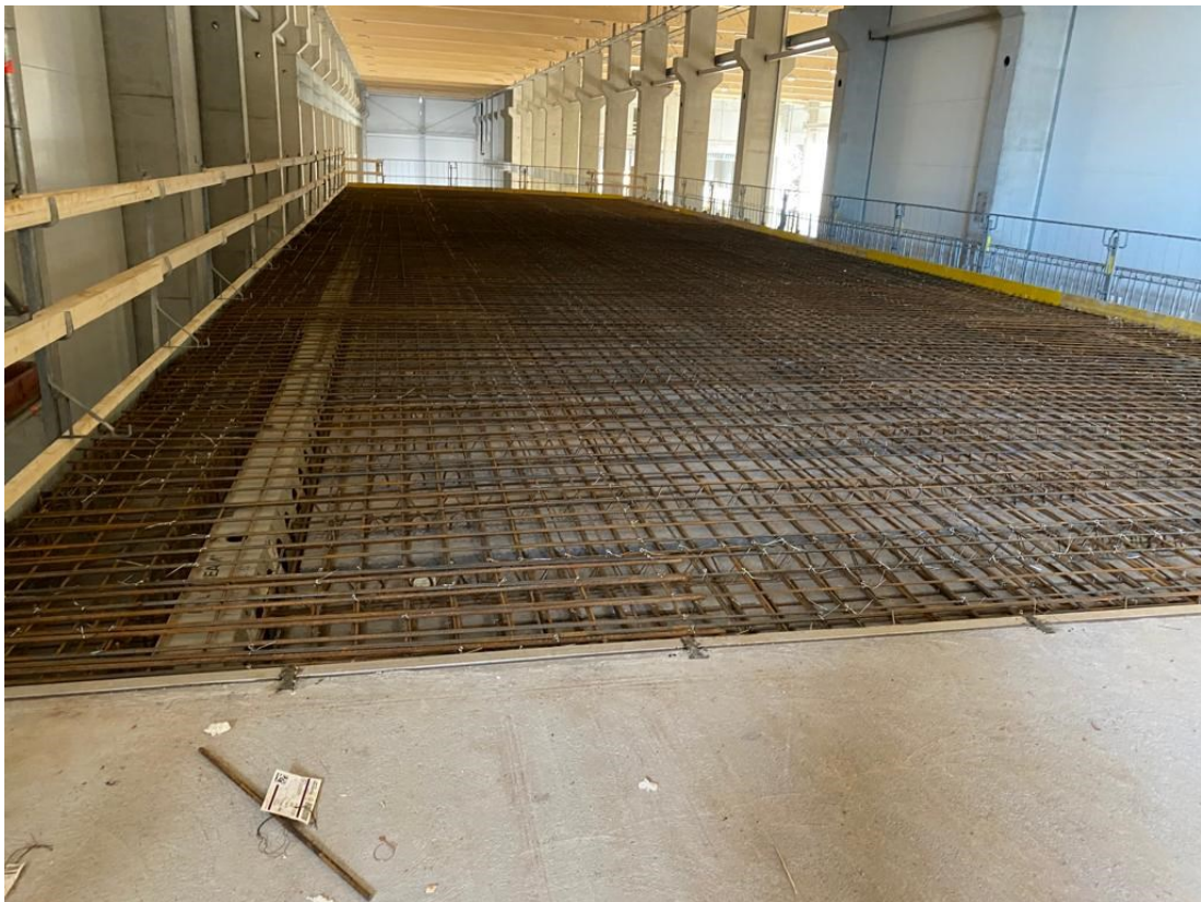
Kuva 11. Putoamissuojaus kaide-elementeistä sekä veivitolpilla ja puutavaralla toteutettuna (Janette Santala, 2021)
