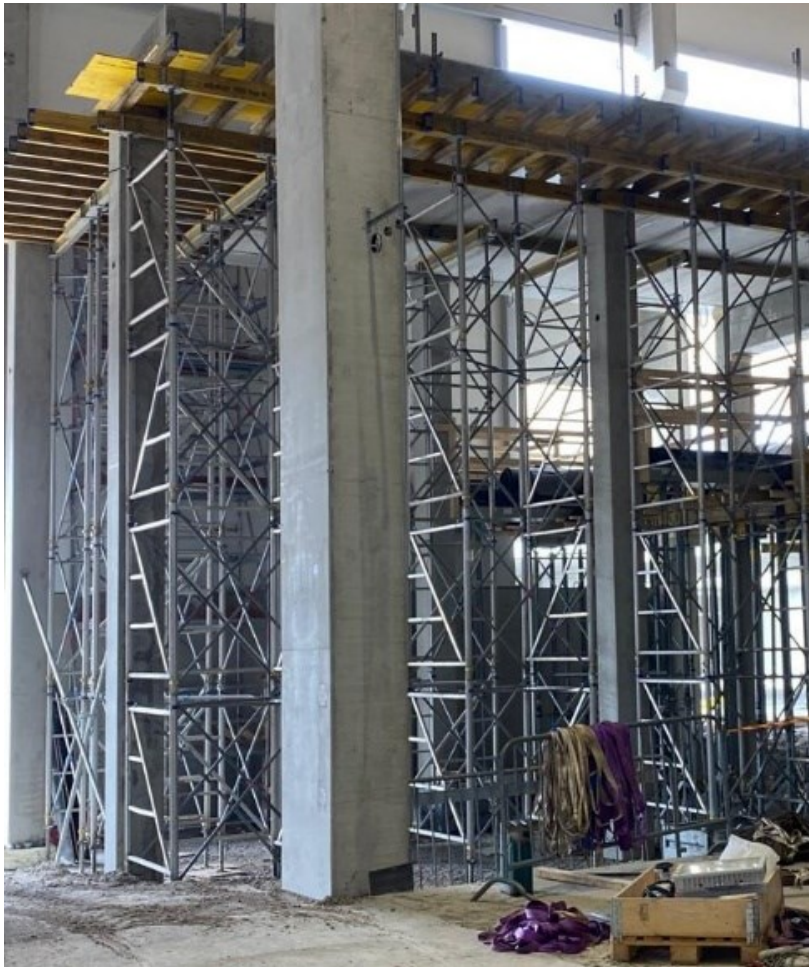
Kuva 13. Tukitornit ja muotin alapuolinen tuenta (Janette Santala, 2021)
