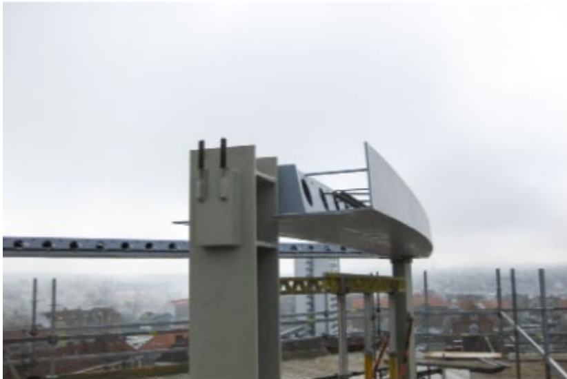
Kuva 14. Deltapalkin valmis peltimuotti (Peikko Group www-sivut , Tekninen käyttö-ohje)
