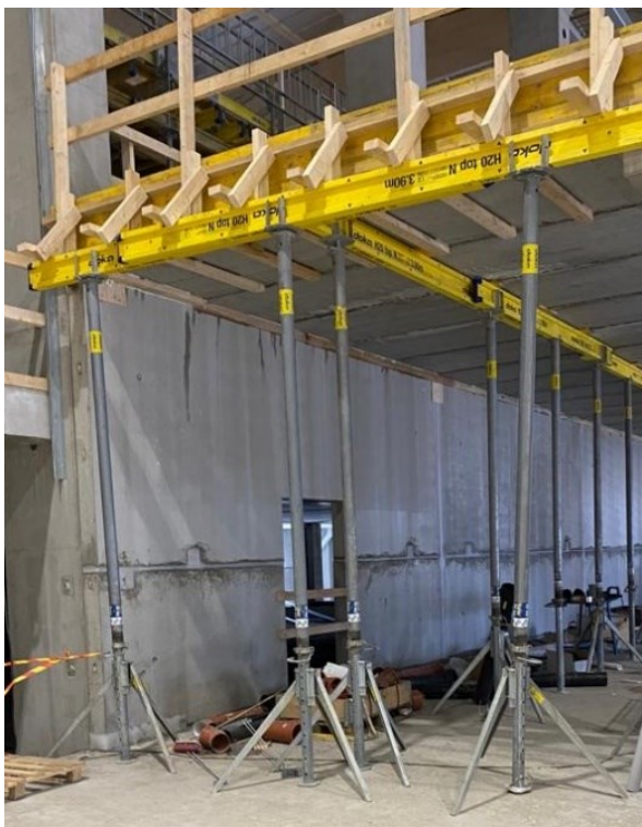
Kuva 3. Puumuotti tuettuna Dokan holvituilla ja palkeilla (Janette Santala, 2021)
