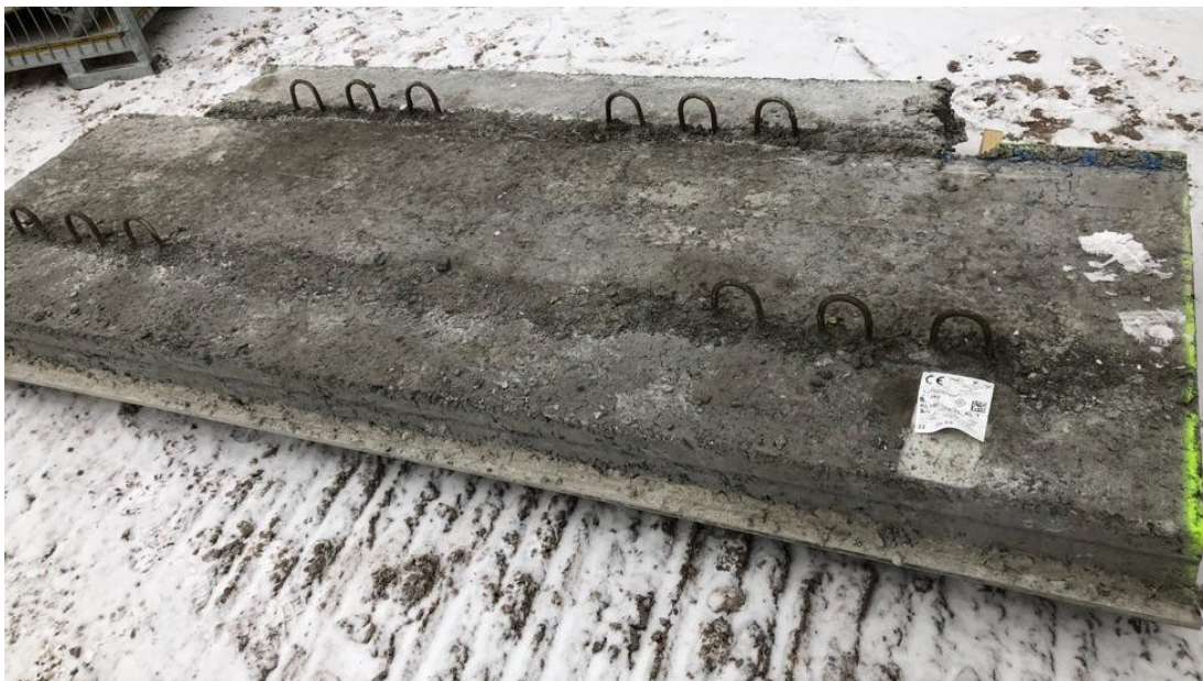
Kuva 2. Kuorilaatta ja siinä olevat ansaat (Janette Santala, 2021)
