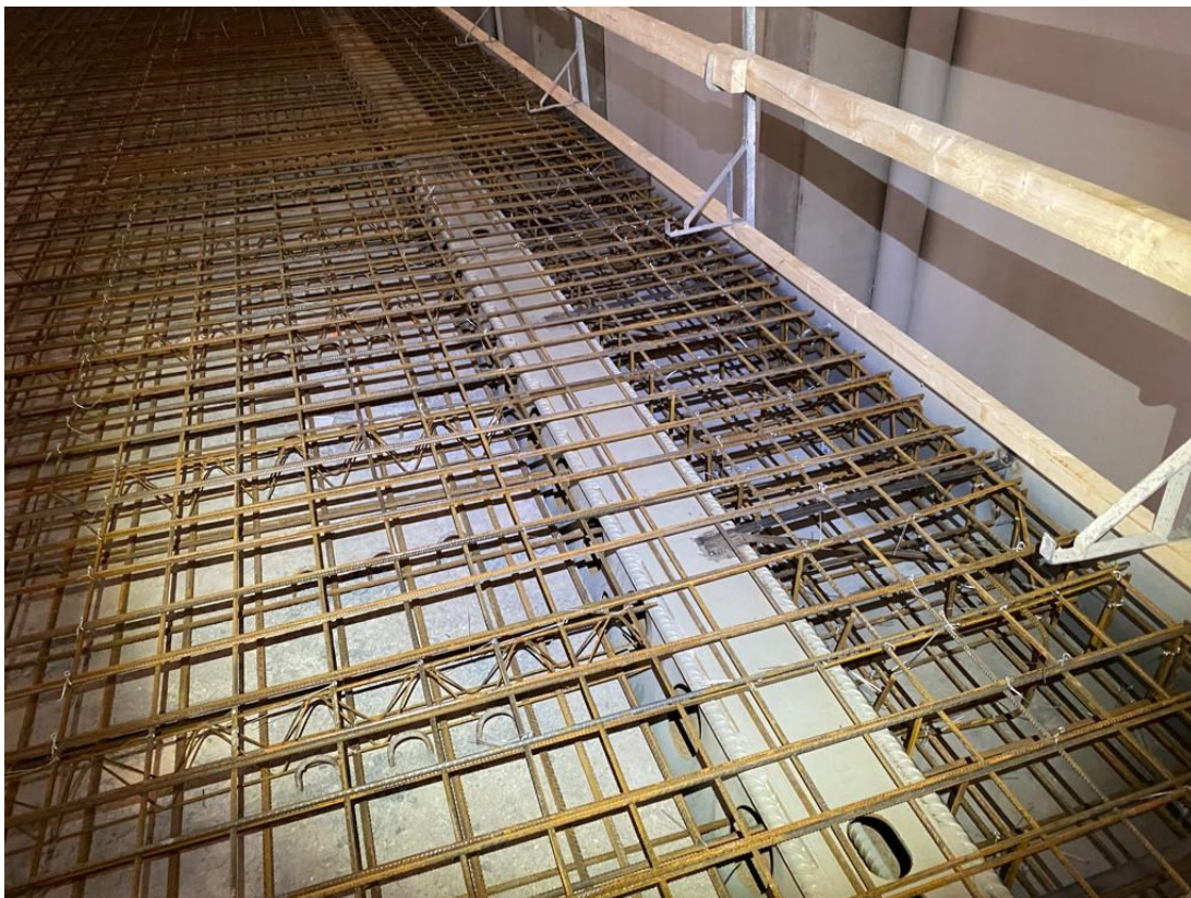
Kuva 12. Peltimuotin kaide ja jäykistävien lattaterästen hitsaukset (Janette Santala, 2021)
