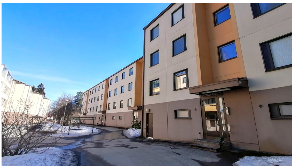
KUVA 23. B-talon pohjoispuoli. (Vähämäki 2022)
