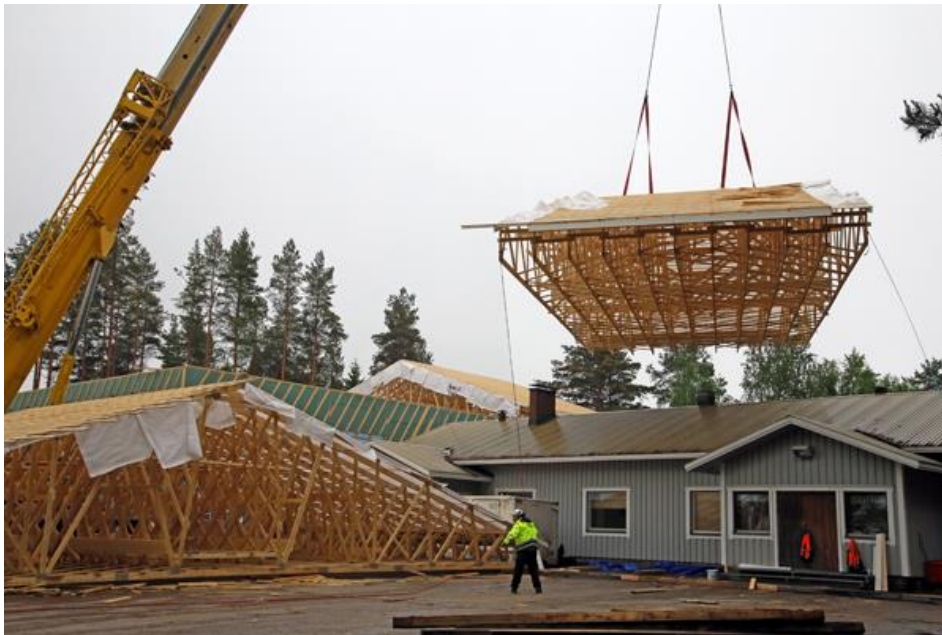
KUVA 2. Liikuntahallin kattorakenteen nosto kattolohkoittain (Timonen 2017)
