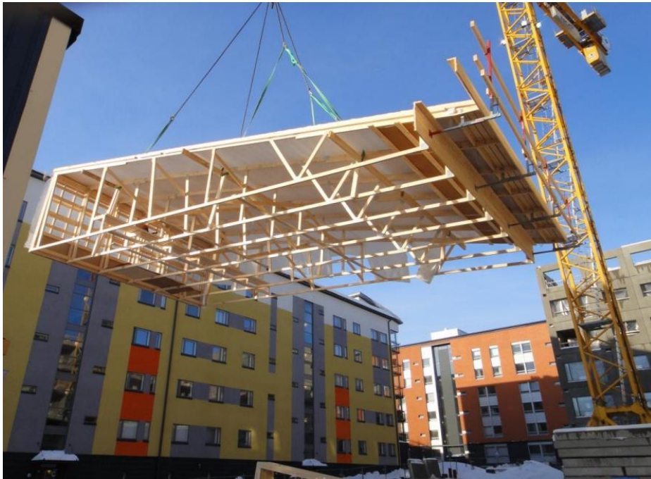
KUVA 1. Kattolohkon nosto kerrostalotyömaalla (Mäkelä 2012)
