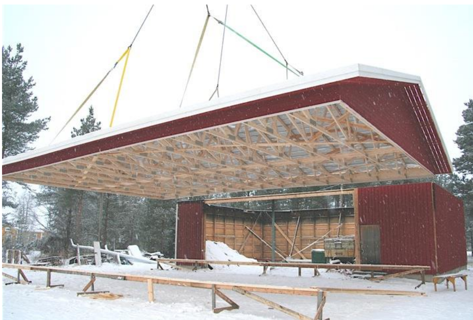
KUVA 3. Varastohallin vesikaton nostotyö kokonaisena (Laulupuu Oy 2009)
