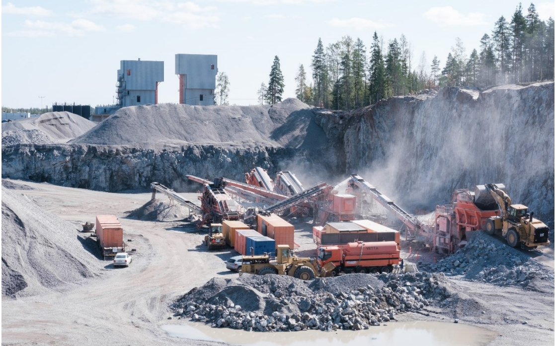
Kuva 3: Pyöräalustainen murskauslaitos Tuusulassa (Mikael Järvenpää, Swerock 2021)
