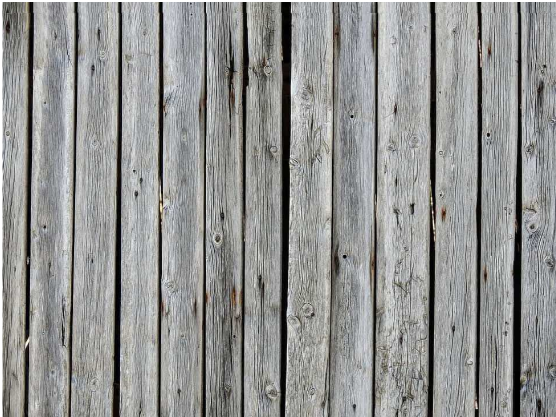
KUVA 18. Lautaverhous käsiteltyä rautasulfaatilla (Uula Color 2019)
