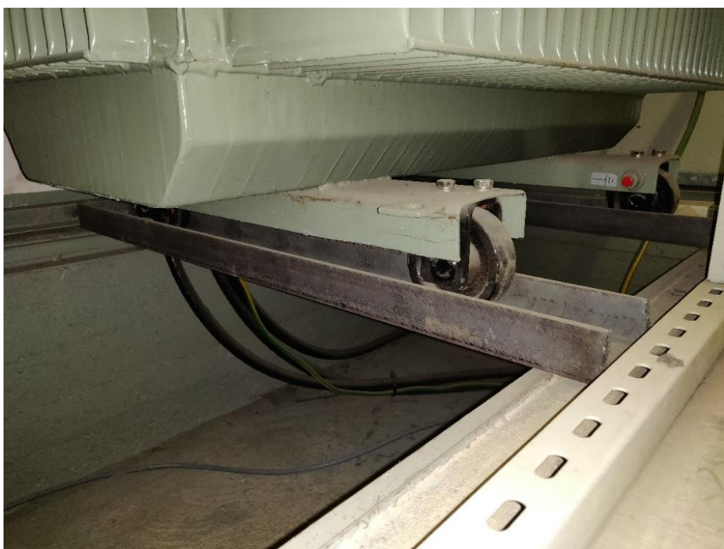
KUVA 3. Kiinteistömuuntaja asemoitu kaapelikuilun yläpuolelle. (Kotilainen 2022, CC BY-NC-ND)
