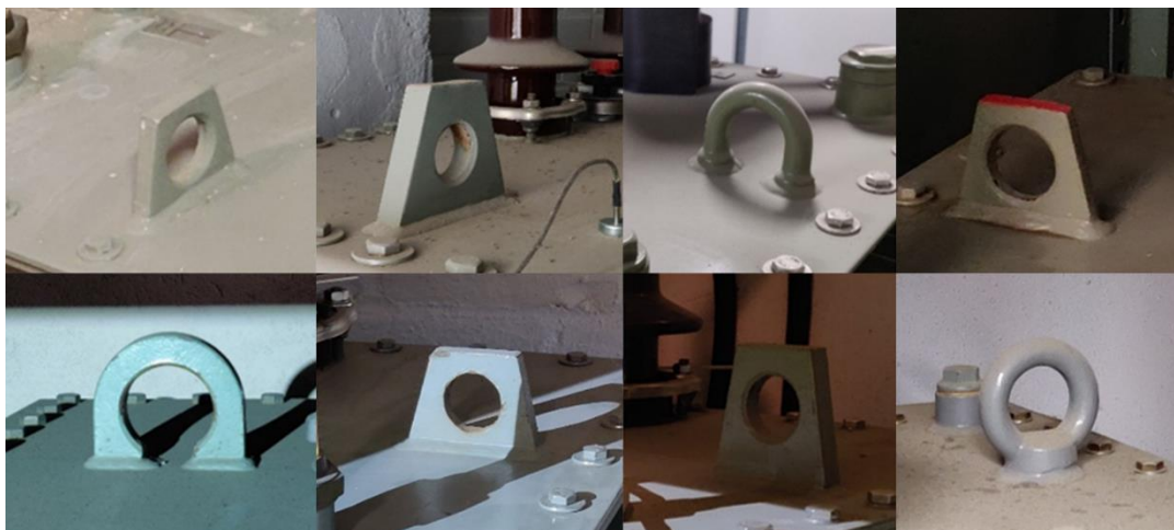
KUVA 4. Kuvakollaasi erityyppisistä nostokorvakoista kiinteistömuuntajissa. (Kotilainen 2022, CC BY-NC-ND)
