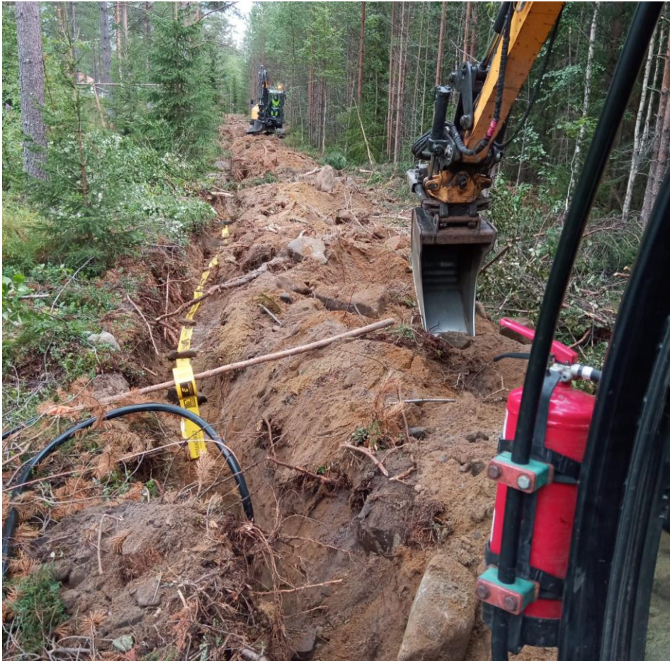
KUVA 9. Kaapelin asentaminen kaivamalla
