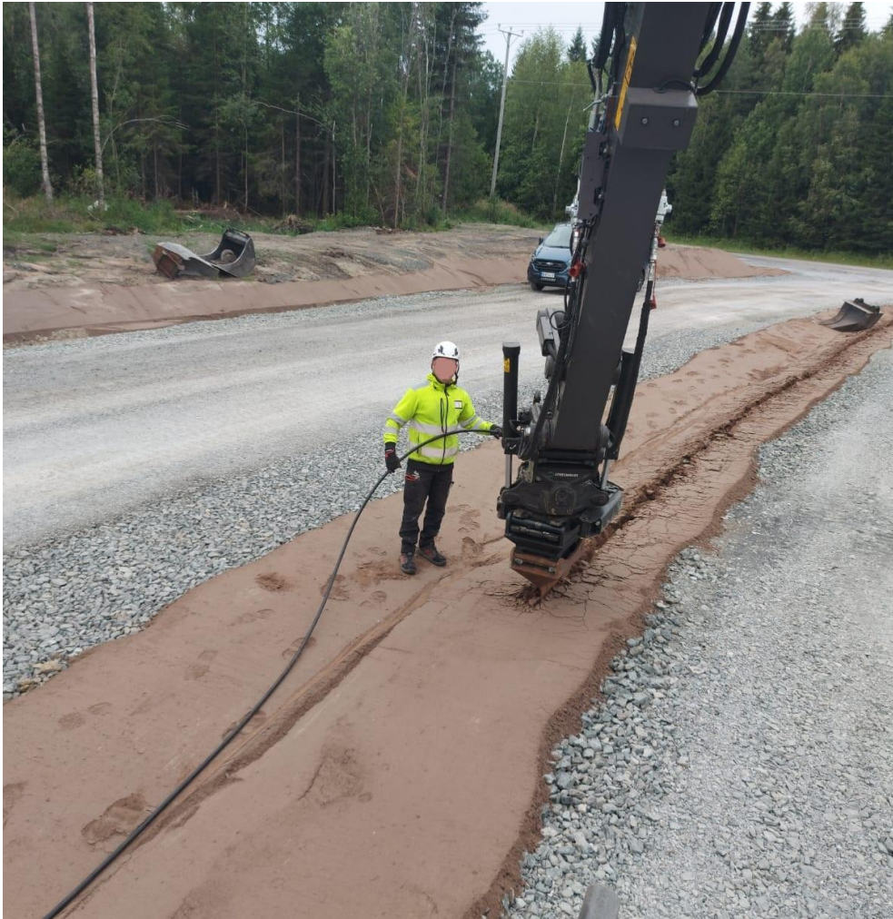
KUVA 10. Kaapelin asentaminen auraamalla
