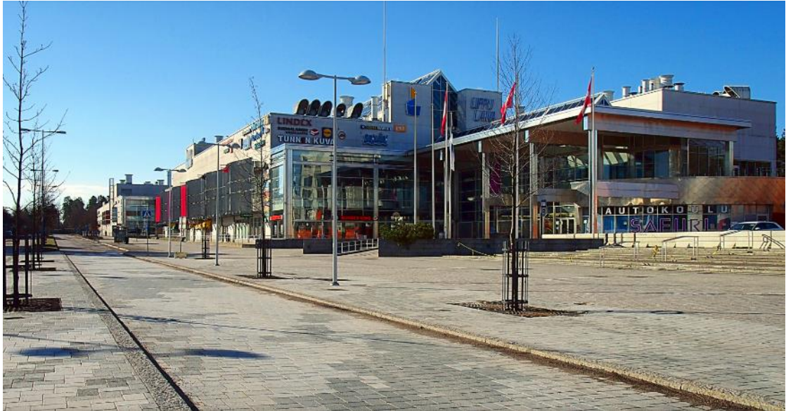
Kuva 5. Vuonna 2017 purettu Lippulaivan kauppakeskus
