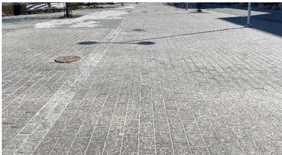
Kuva 3. Lippulaivan valmis graniittilaatoituksella tehty Ulappatori
