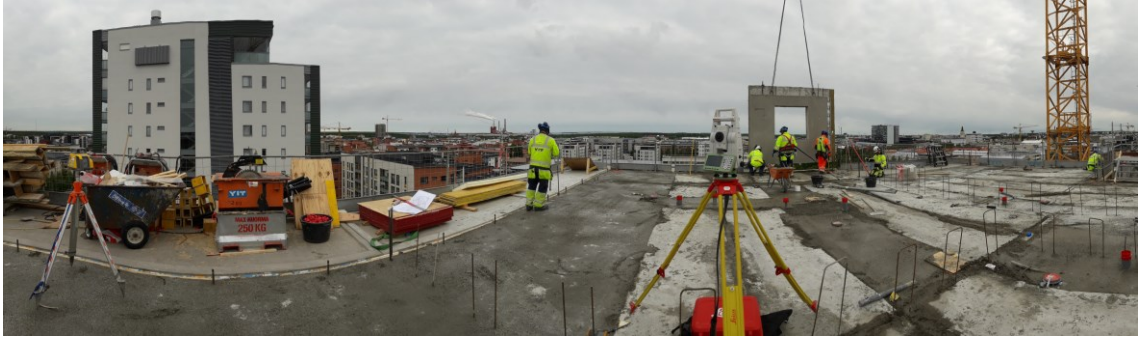
Kuvio 4. Leica Viva TS16 takymetri rakennustyömaalla Oulussa kesällä 2018. Liitospisteet, joiden avulla orientointi tehtiin, sijaitsivat esimerkiksi naapurikerrostalojen katoilla tai seinissä (Kuusela, 2018).
