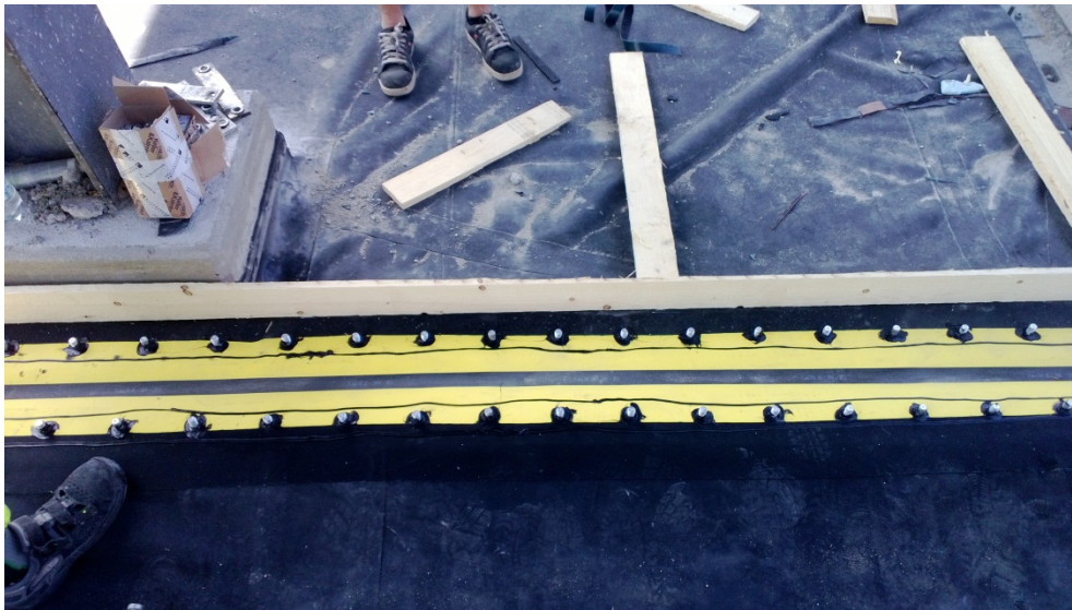
KUVA 6. Liikuntasaumalaitteen asennusta
