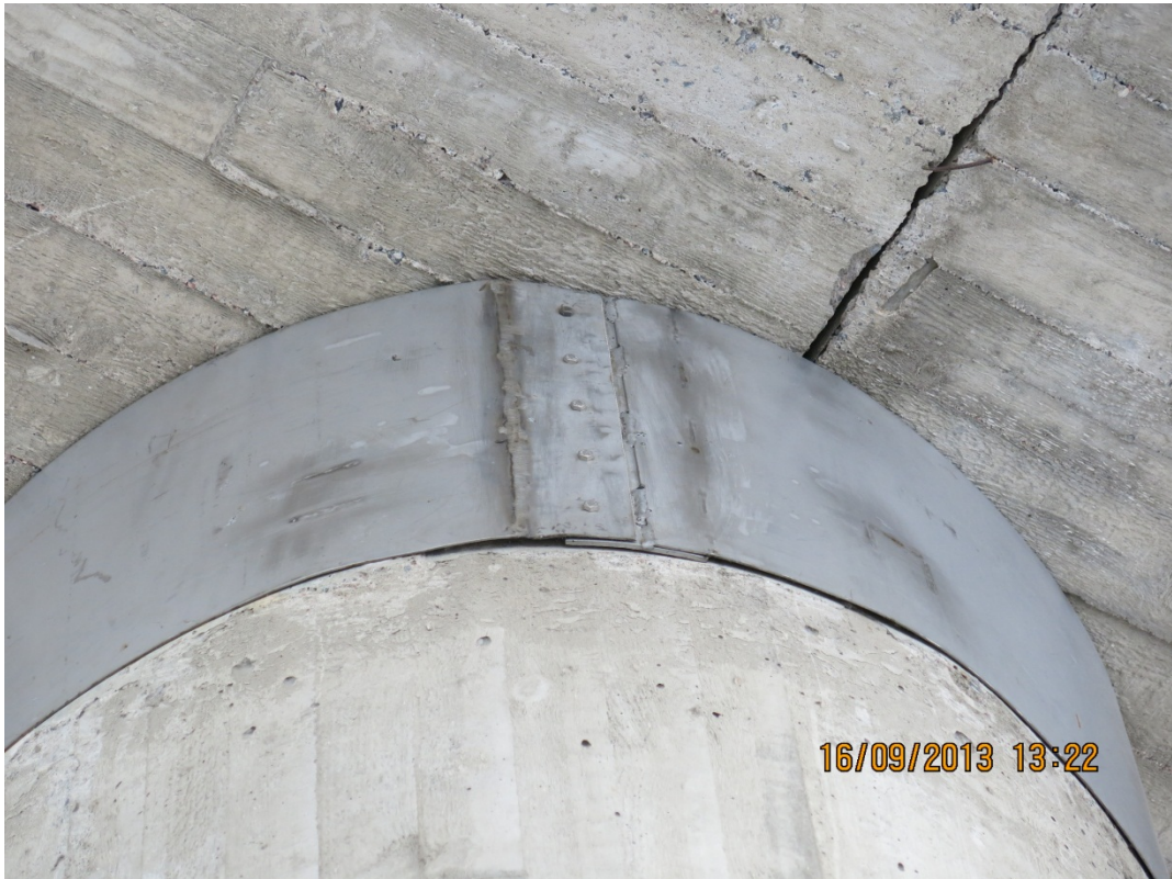
KUVA 8. Laakereiden teräksinen suojavanne
