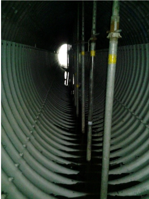
Kuva 14. Holvituet asennettuna betonivalua varten
