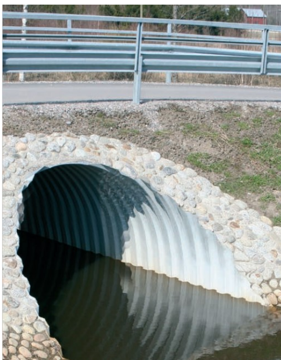
Kuva 1. Teräspanksilta (Rumtec Oy, 2013)
