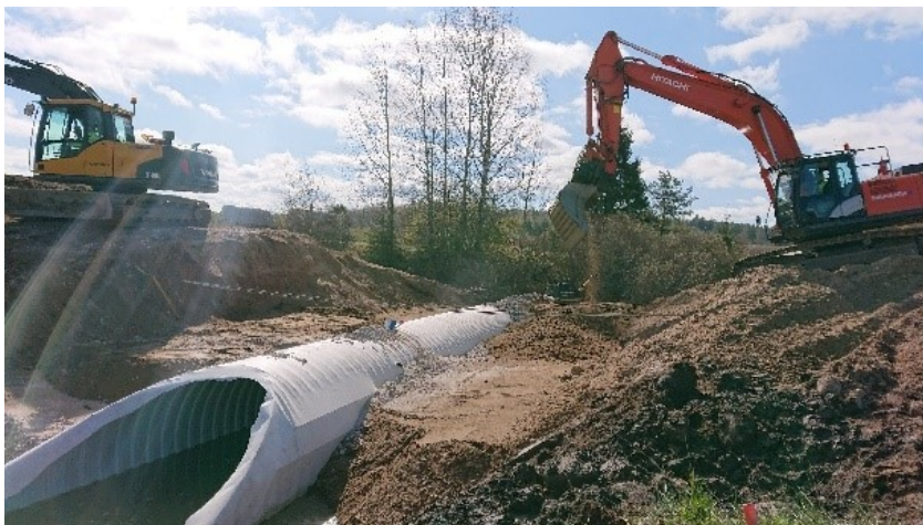
Kuva 7. Putkisillan uusiminen auki kaivamalla
