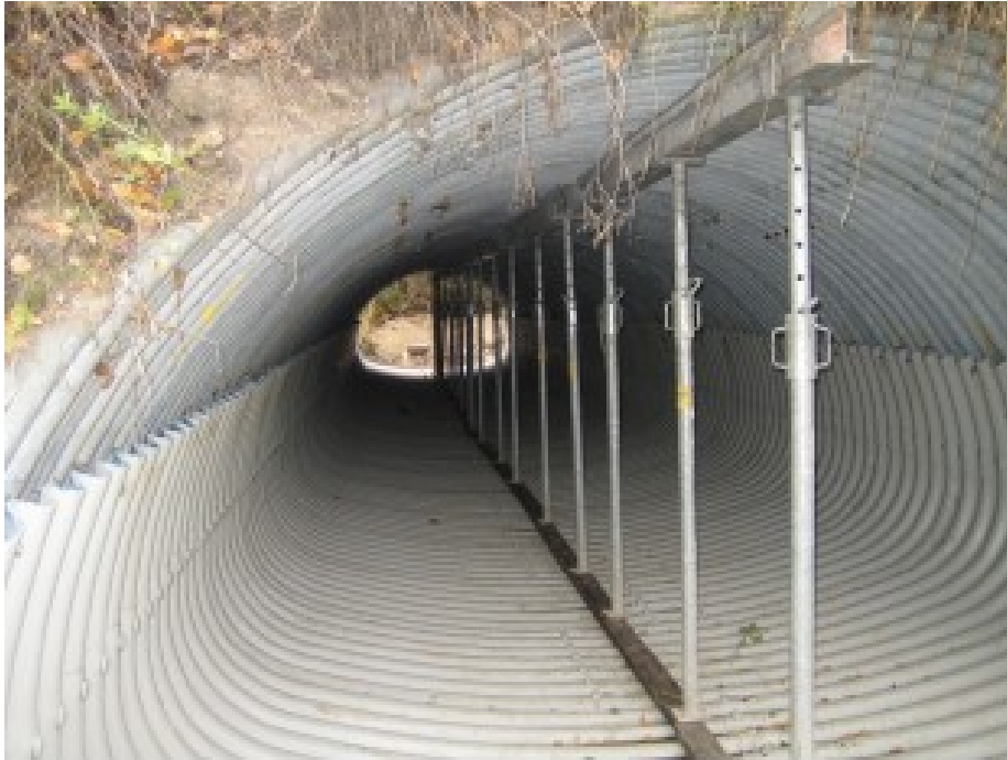
Kuva 13. Puolipohja sujutettuna (Tiehallinto, siltatekniikka, 2006)
