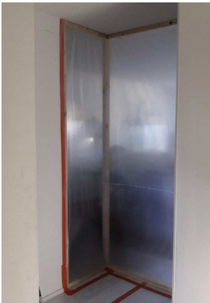
Kuva 5. Kulmaosastointi väliseinätolpista rakennettuna
