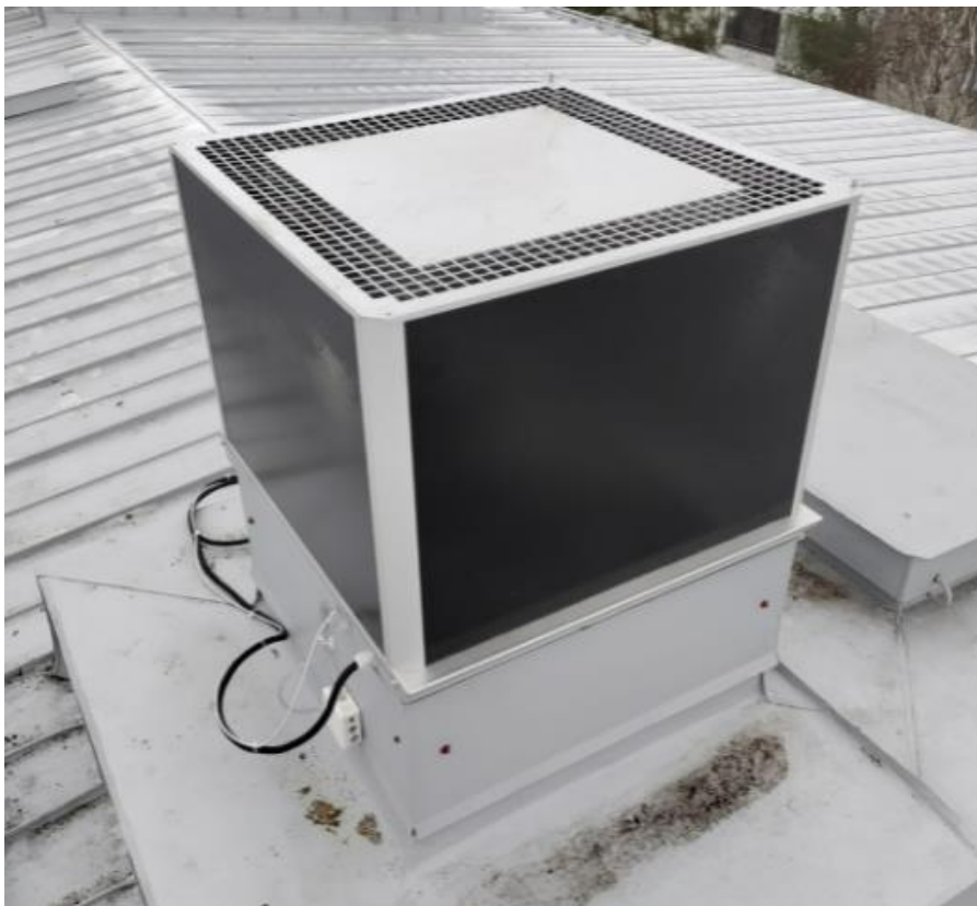
Kuva 19. Uusi EC-huippumuri vanhan hihnavetoisen puhaltimen läpiviennin päälle asennettuna [24]
