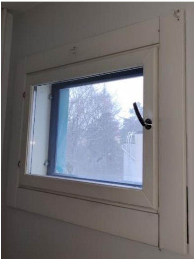
Kuva 16. Apukeittiön ikkuna ennen karmiventtiilin asentamista [8]
