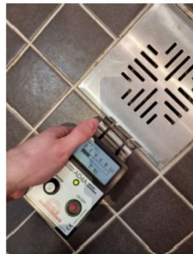
Kuva 23. PH lattiakaivo. Pientä pintakosteutta 2,8 %.
