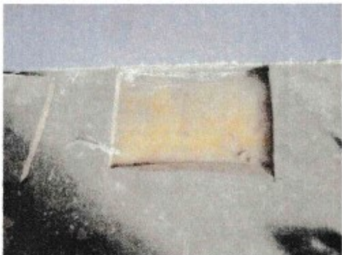
Kuva 26. Pesuhuoneen seinän viereinen avaus.
