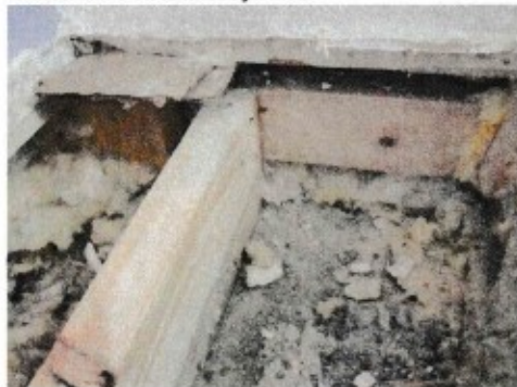
Kuva 20. Mineraalivillaa on työlaatan päällä.
