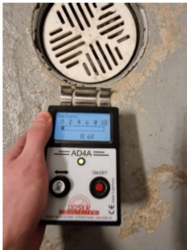
Kuva 18. Kellarin lattiakaivo. Pientä pintakosteutta 0,6 %.
