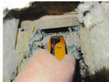
Kuva 15. Sokkelin pinta on kostea, villaa pinnalla. Alushuopa ei ole koko sokkelin päällä.
