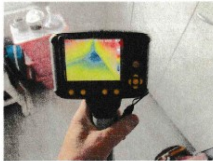
Kuva 9. Mh, TI 60 (korjausluokkasuositus 1). (alin pistemäinen lämpötila 8.5 °C)
