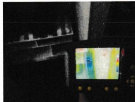
Kuva 6. Ilmavuotoa tuulikaapissa, TI 52. (korjausluokkasuositus 1, alin pistemäinen 6.2°C).
