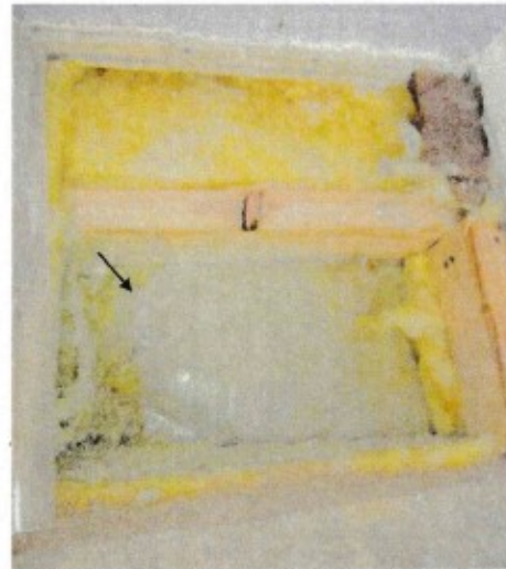
Kuva 19. Ulkoseinän höyrnsulkumuovi ulottuu lattiaan päin. Muovin alla 5 cm villa.
