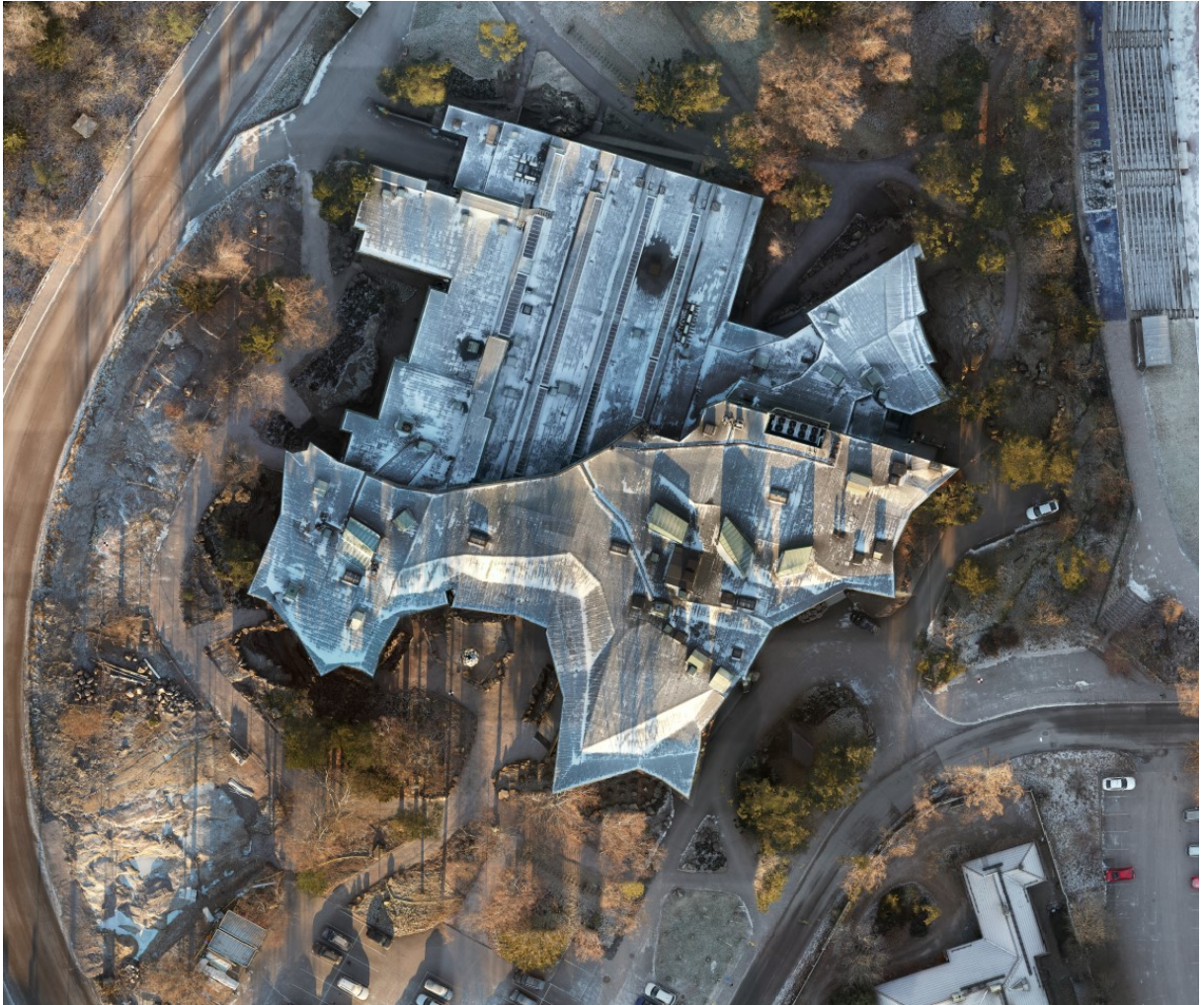
Kuva 16. Ortokuvaus Zenmuse P1 -kameralla Aalto-yliopiston Dipoli-rakennuksesta (Forsell, 2021)
