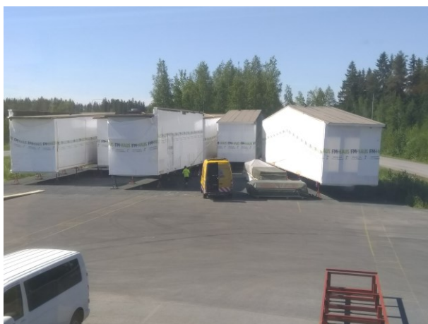
KUVAT 42. ja 43. Muoviin pakatut moduulit valmiina siirtymään tehtaalta työmaalle (Vierre 2022)
