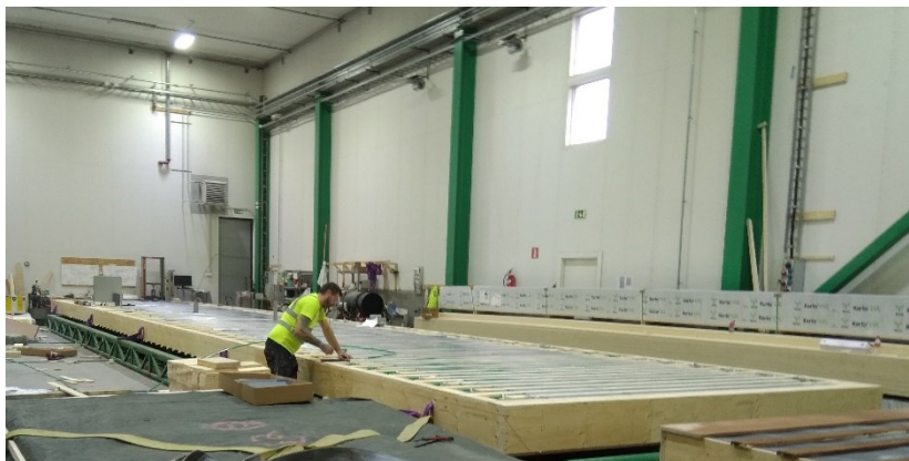
KUVA 1. Lattialämmityksen asentamista lattiaelementtiin (Vierre 2020)
