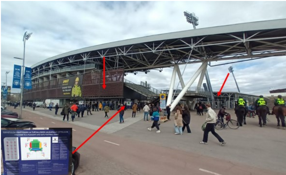
Kuva 15. Eteläpäädyn sisäänkäyntien opastus näkyy huonosti (28.4.2022).
