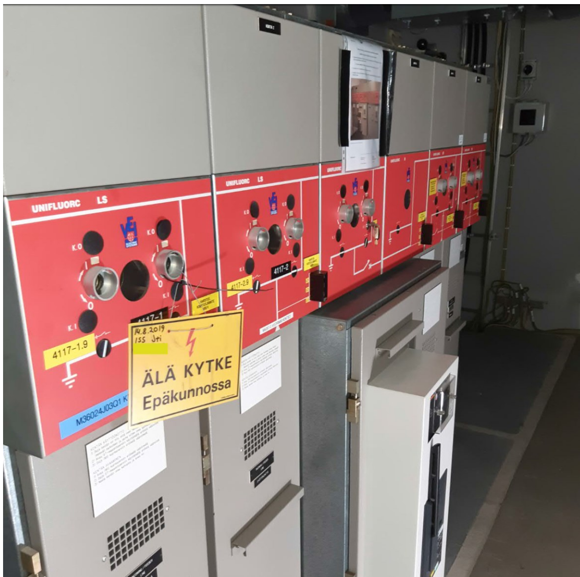
Kuva 6. Purettu vanha Unifluorc LS - asiakaskojeisto (15.)
