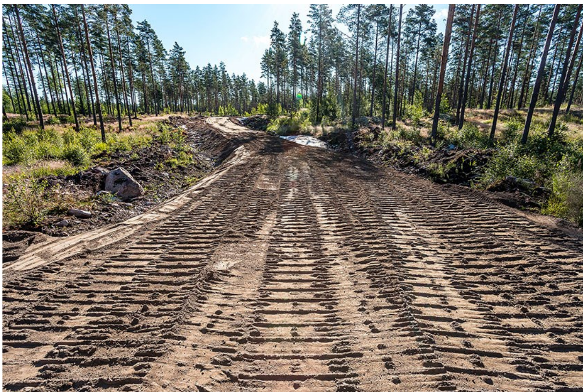
Kuva 7. Tuhka toimii tierakenteessa (Heikkilä 2020).
