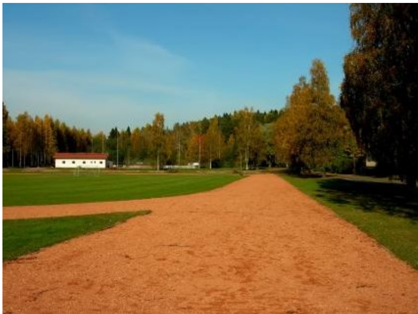
Kuva 5. 0–4 mm Tiilimursketta urheilukentällä, (Raikkonen Oy 2022)
