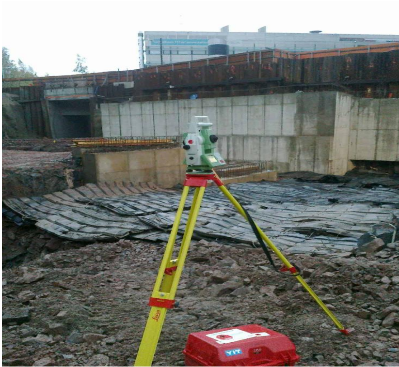
Kuva 2. Robottitakymetri Leica TS 15 mittausvalmiina
