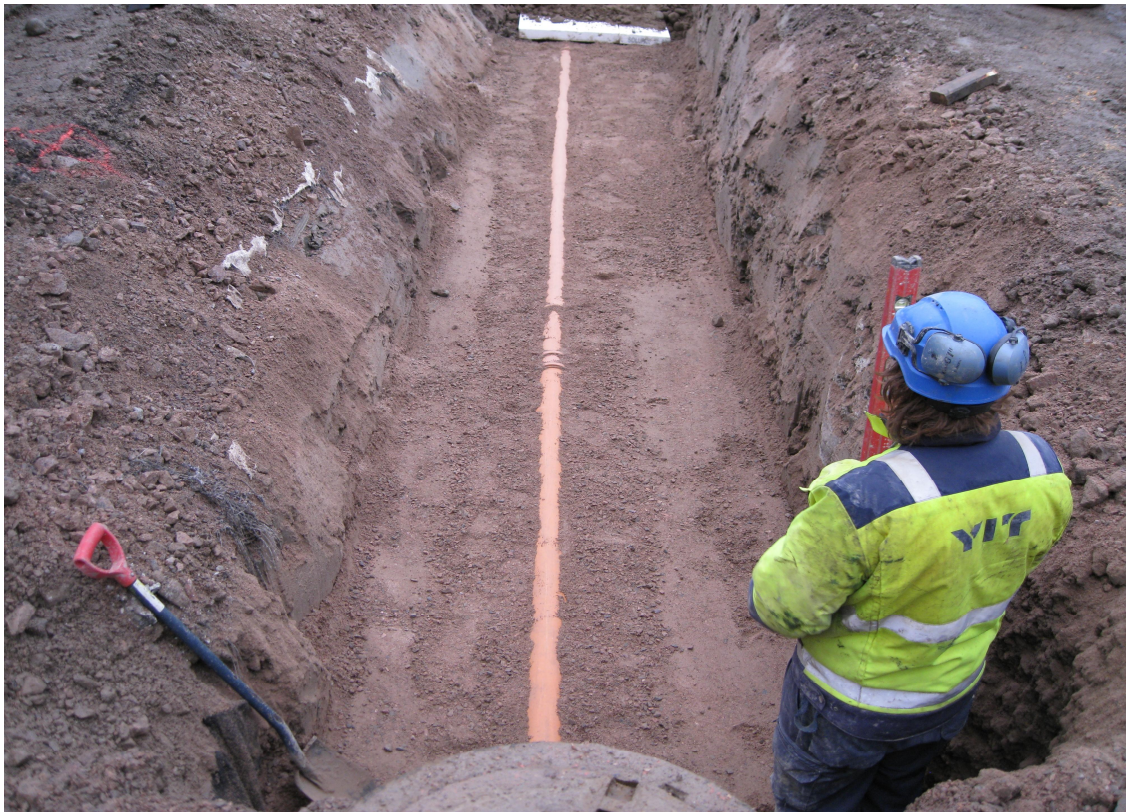
Kuva 15. Sadevesikaivannon täyttö käynnissä tarkistusmittauksen jälkeen
