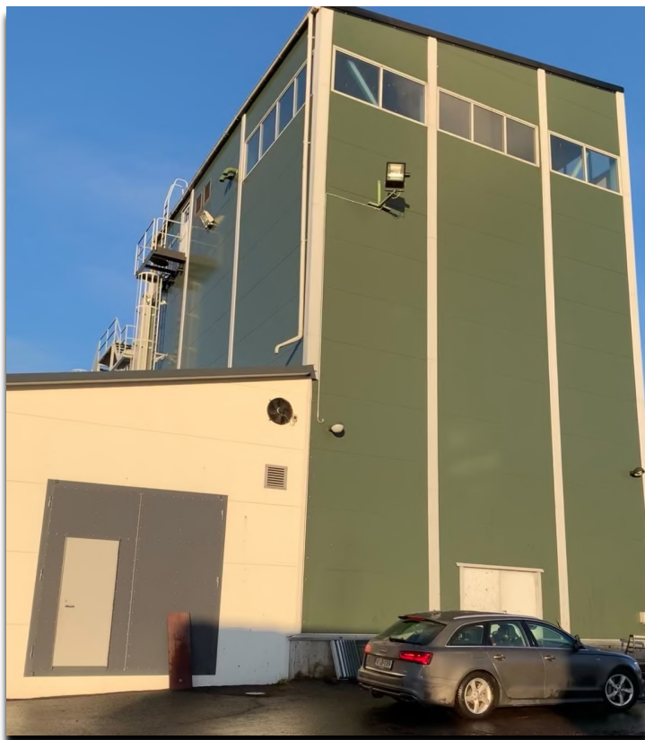
Kuva 1. Isojoen Lämpö Oy:n kattilarakennus.
