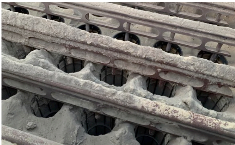
Kuva 12. Savukaasusuodattimen paineilmapillejä ja niistä lähteviä suuttimia.
