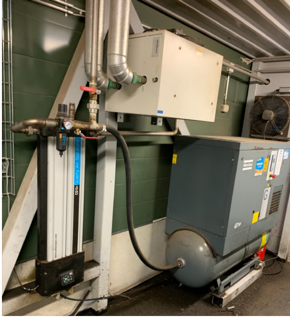
Kuva 8. Savukaasusuodattimen paineilmajärjestelmän kompressori, paineilmasäiliö ja paineilman adsorbtiokuivain.
