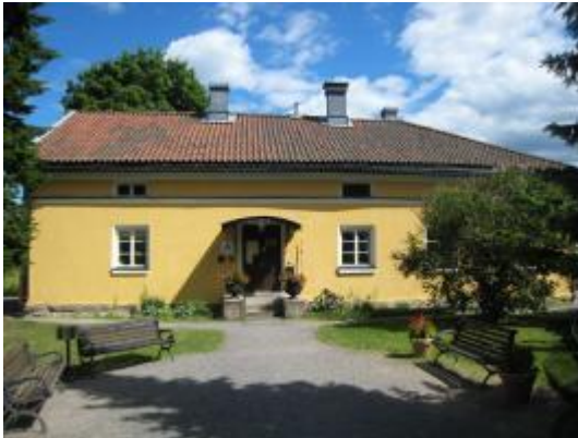
Kuva 2. Tuorlan Majatalon päärakennus (Ravintola-arvioinnit 2014)
