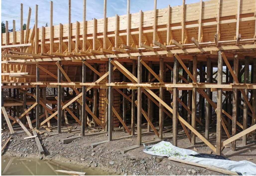
Kuva 2. Kehä 3 maantiesillan telineet
