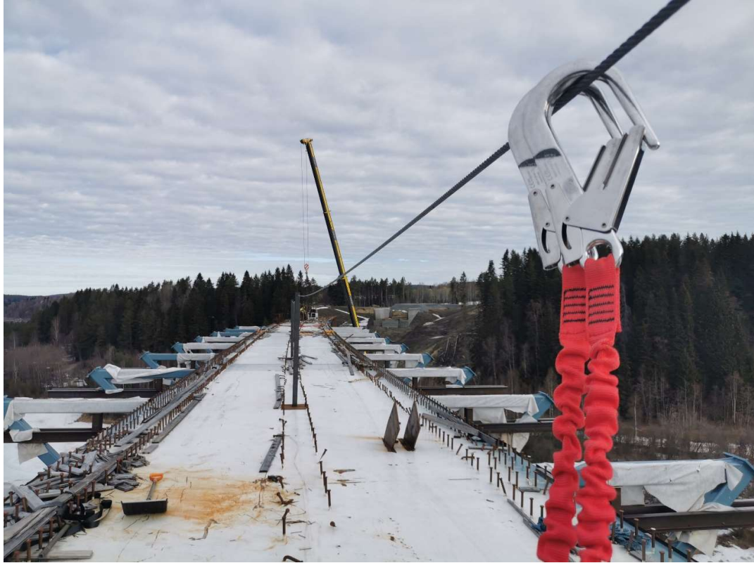
Kuva 5. Vaijerilinja käytössä Umeå:n siltatyömaalla
