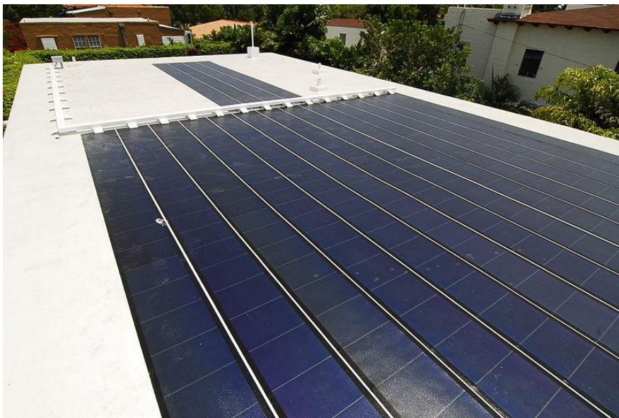
KUVA 7. Ohutkalvopaneelisto asennettuna katolle (Wikipedia 2014.)
