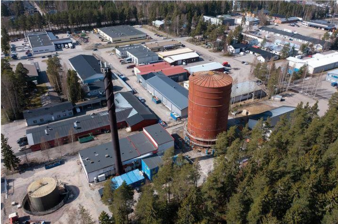
Figur 1. Bild av Borgå energis fjärrvärmeackumulator i byggnadsstadiet.
