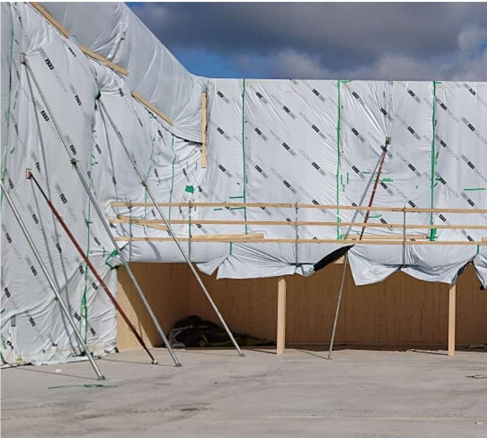
Kuva 6. Elementtituet ja tason kaiteet.
