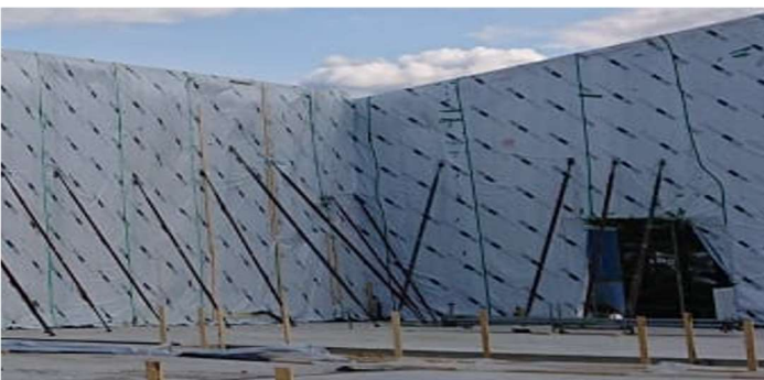
Kuva 5. CLT-elementit suojattuna.
