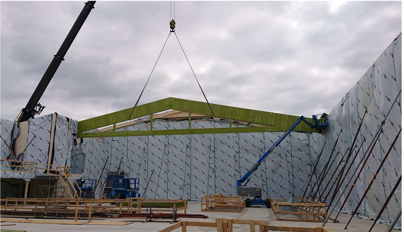
Kuva 4. Kattoristikon kiinnitys henkilönostimesta.
