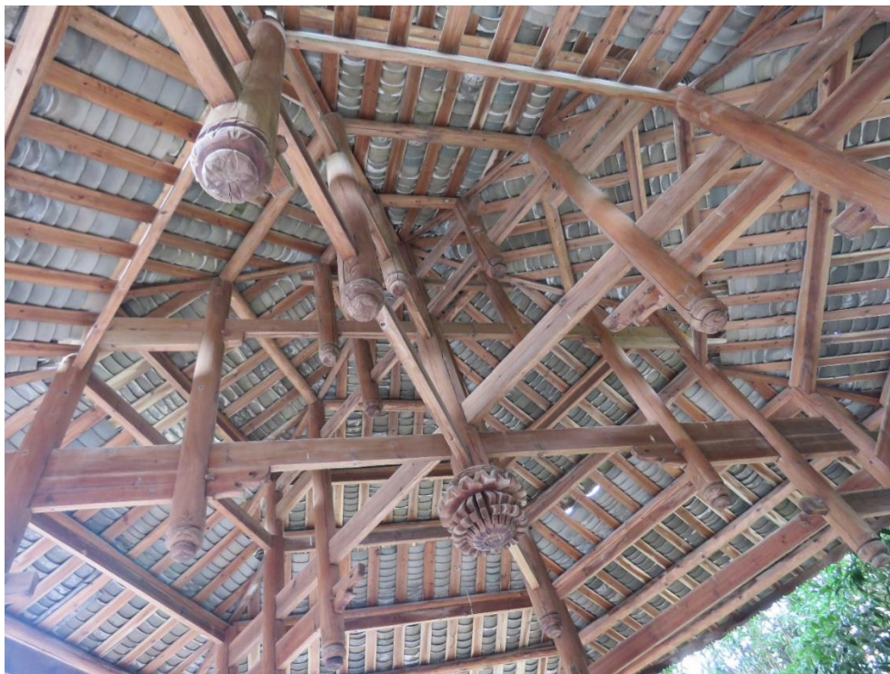
KUVA 41. Kattoristikkorakenne perinteisellä kiinlaisella tekniikalla (Mika Leinonen)
