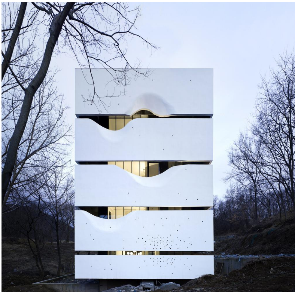
KUVA 18. CIPEA No.4 House, AZL Architects (Yao Li)
