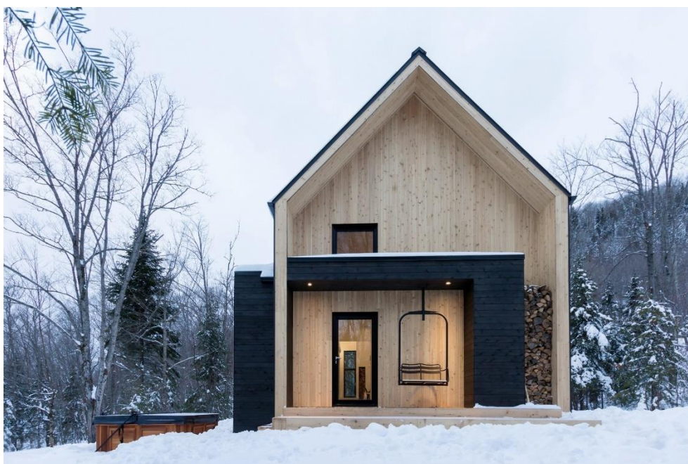
KUVA 6. Villa Boreale, CARGO Architecture (Dave Tremblay)
