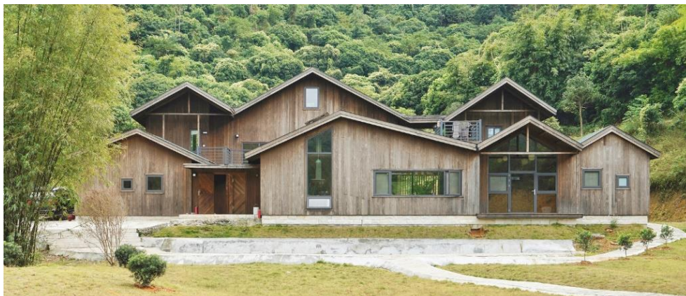
KUVA 23. Hus V, Credohus (Kayan Chow)
