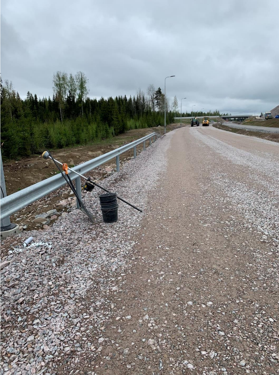
Kuvio 7 Väylä M2 paalu 0 valmis rakenne.
