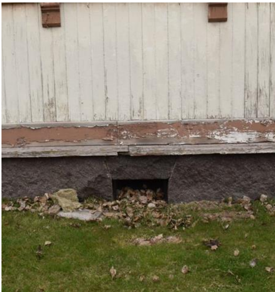
KUVA 15. Kellarin tuuletusluukku (Tolonen 2021)
