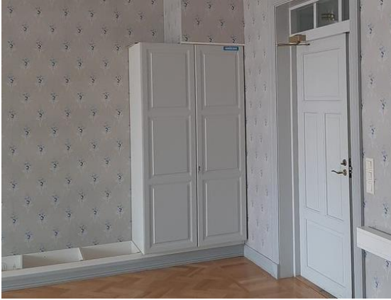
KUVA 19. Tekniikkaa osittain puretussa kaapistossa ensimmäisessä kerroksessa
