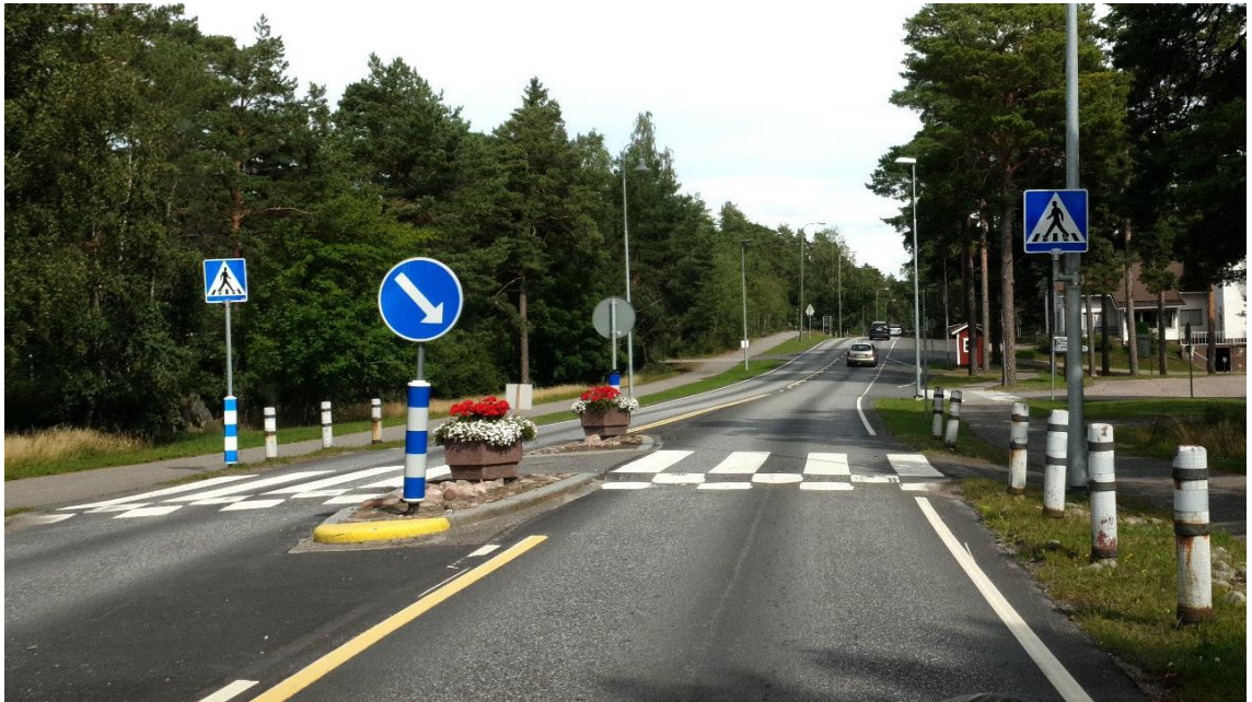
Kuva 4. Korotettu keskisaarekkeellinen suojatie.
