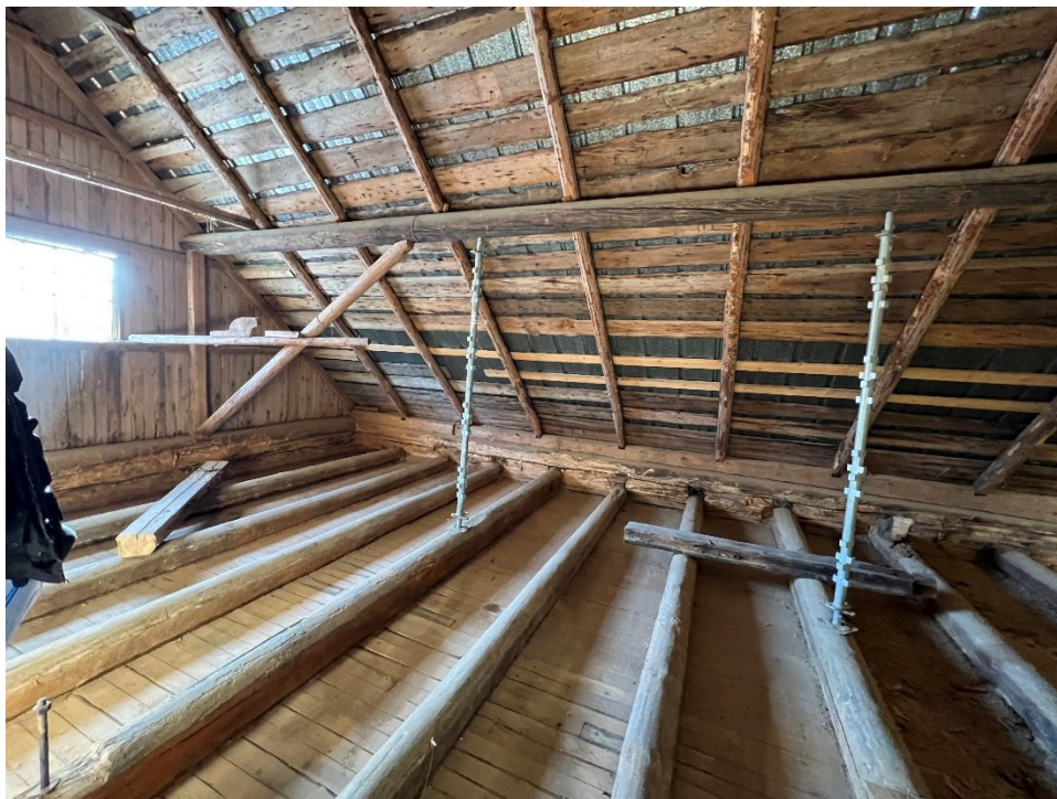
KUVA 25. Raakapinnalla oleva vintti, purut imuroituna tuvan yläpohjasta (Koivistoinen 2022)
