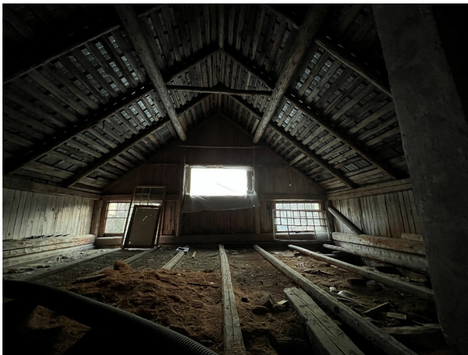
KUVA 31. Tuleva kesähuone lähtötilanteessa (Koivistoinen 2021)
