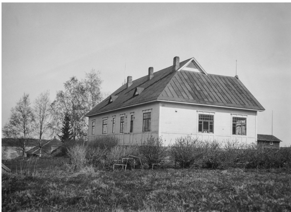
KUVA 47. Rakennus kuvattuna luoteesta alkuperäisessä asussaan (Laitisten kotialbumi)
